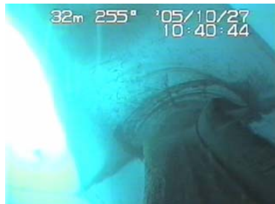
図3 廊下の下部に設けた筒網の状況
