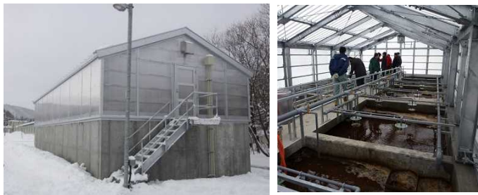
排水処理施設（水産資源研究所 徳志別さけます事業所）
