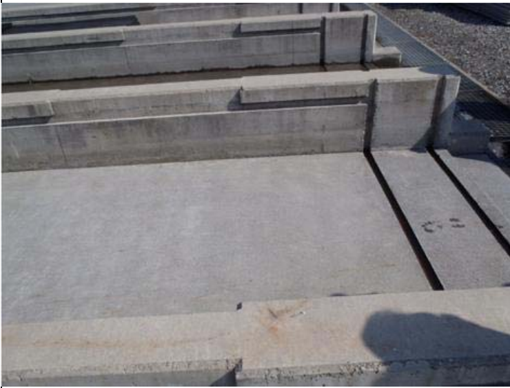
飼育池排水部が地盤沈下により下がっている 地盤改良方法を助言
