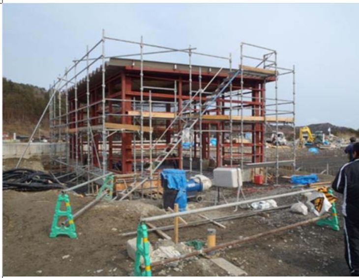
電源棟施工中、手前が井戸(アクアジオテクノ)
