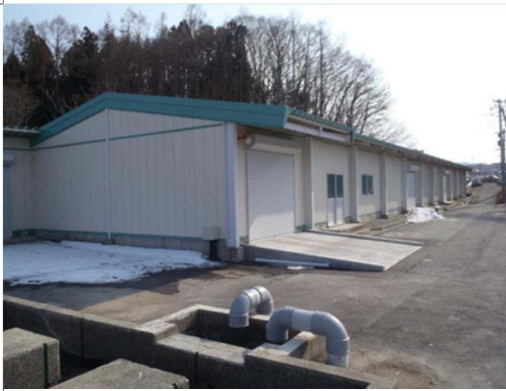
改修第1ふ化室
