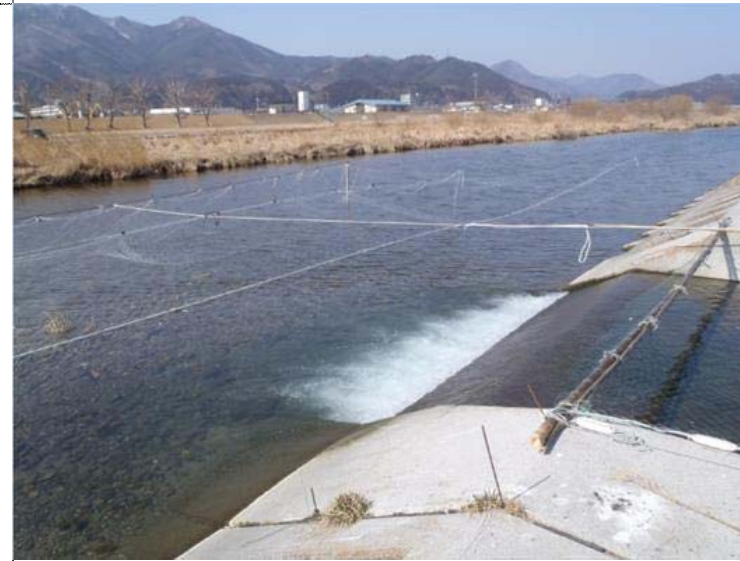
放水路等もネットで防鳥対策
