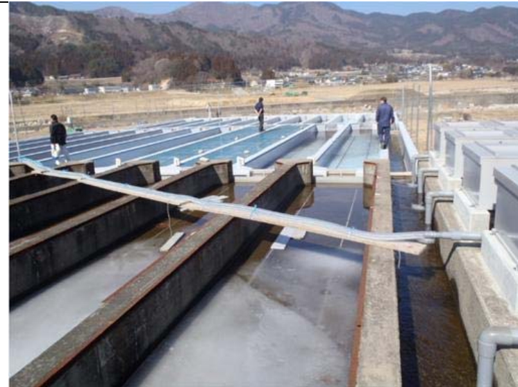
浮上槽より降下中
