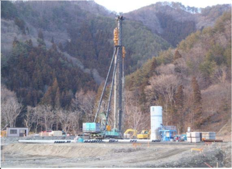
新設ふ化場: 施工中 杭打ち、井戸掘削
