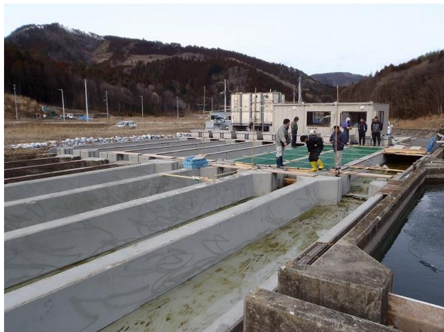
H25年2月26日(H24第2次現地調査) 宮城県石巻市 宮城県漁協雄勝湾支所 大原川ふ化場
