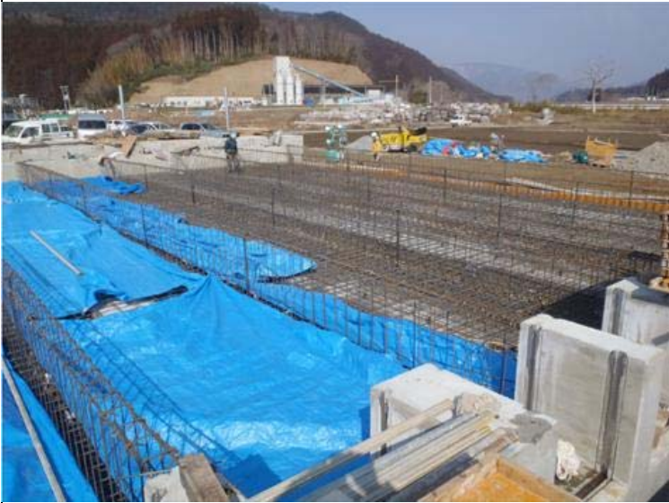
飼育池：配筋、型枠設置中
