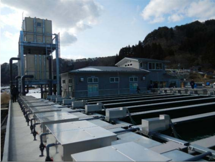
第2ふ化場、曝気槽、配水槽、管理棟(1階はふ化施設等、2階は事務室)
