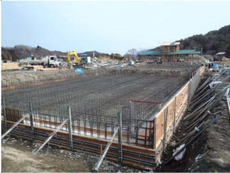
飼育池：配筋、型枠設置中
