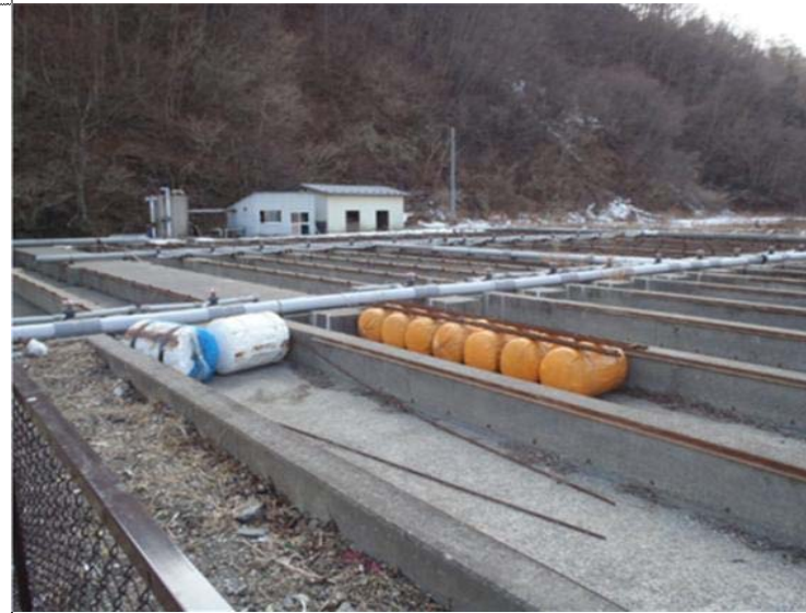
復旧整備予定の第1施設(コ ンクリート池)
