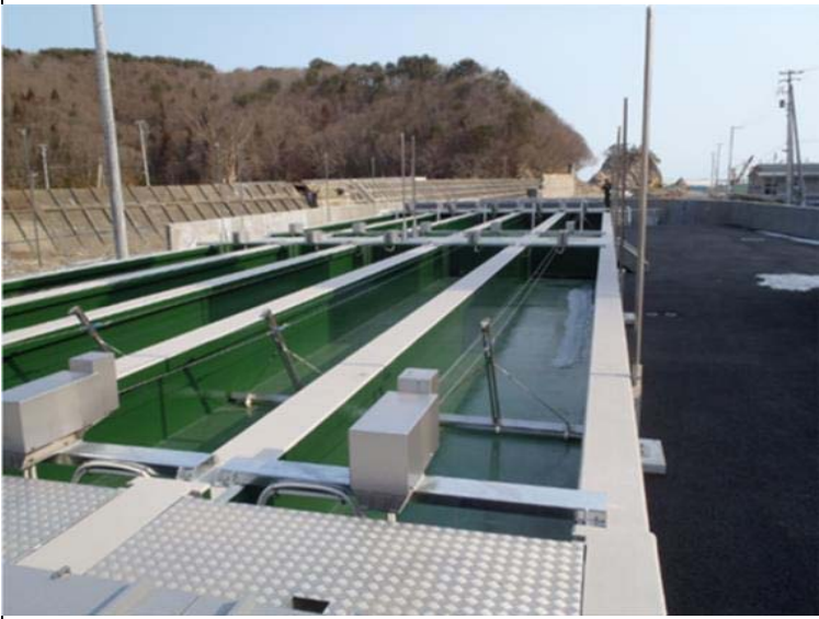
第1施設(A池)施工終了
