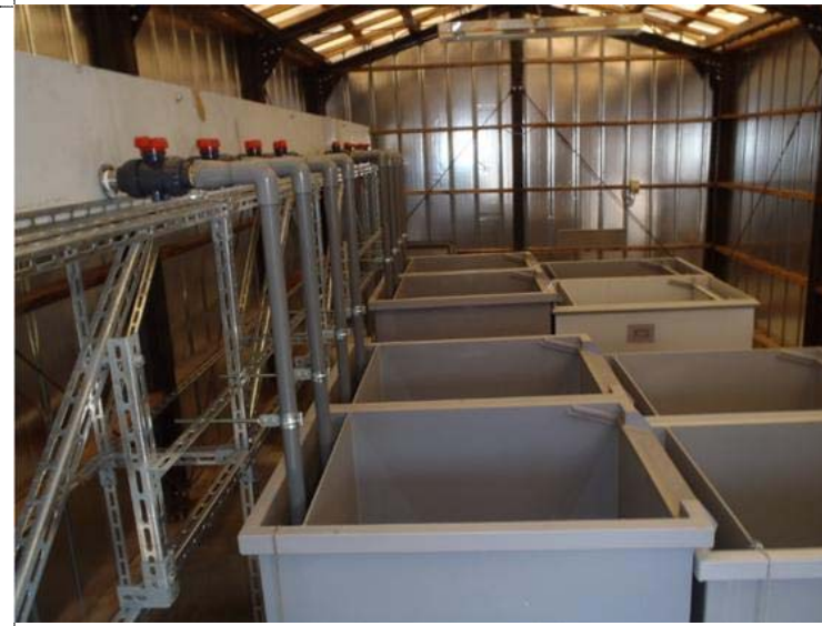
飼育池排水部が地盤沈下により下がっている 地盤改良方法を助言
