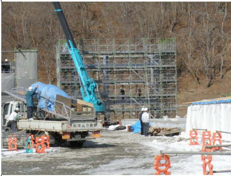
配水槽架台、設置中
