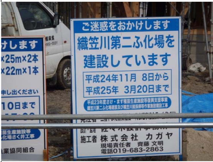
新設ふ化場施工中
