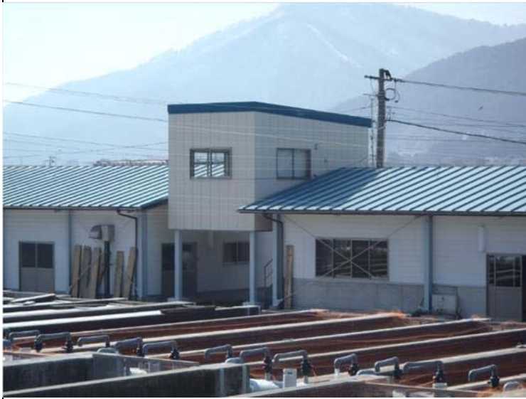
2階建て管理棟施工済み
