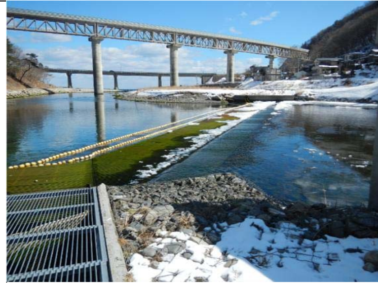
放水路(魚道)及び捕獲止め
