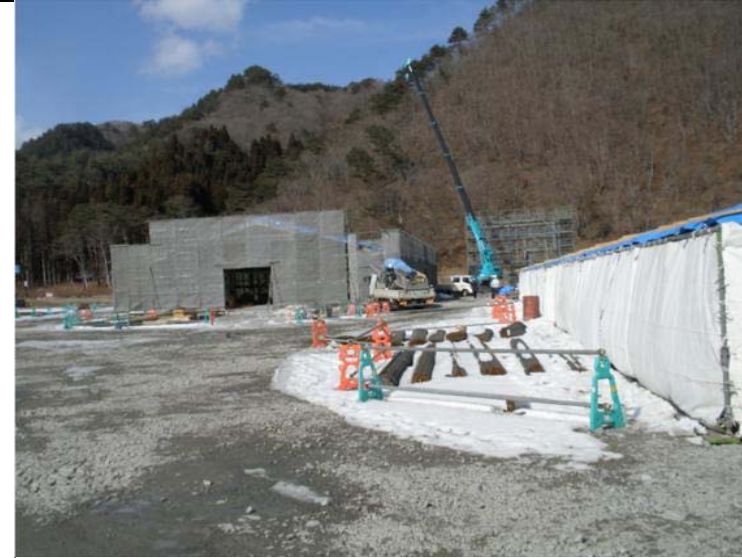
ふ化施設施工中
