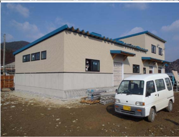
新設ふ化場管理棟
