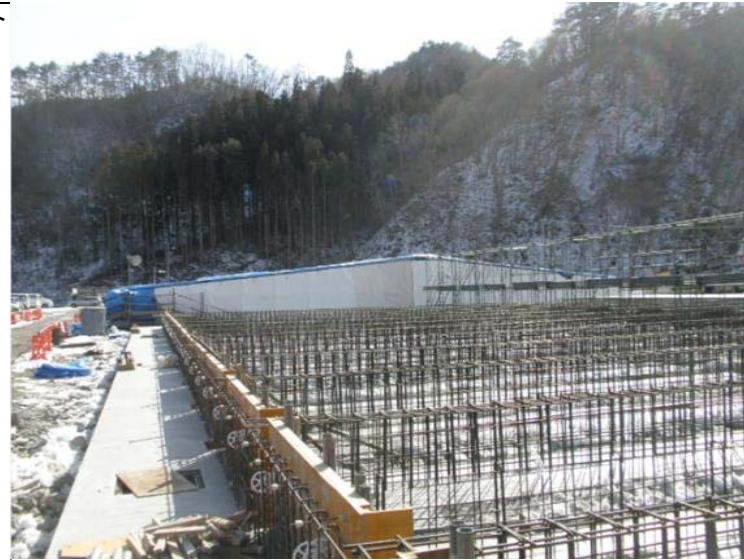
飼育池: 配筋設置中
