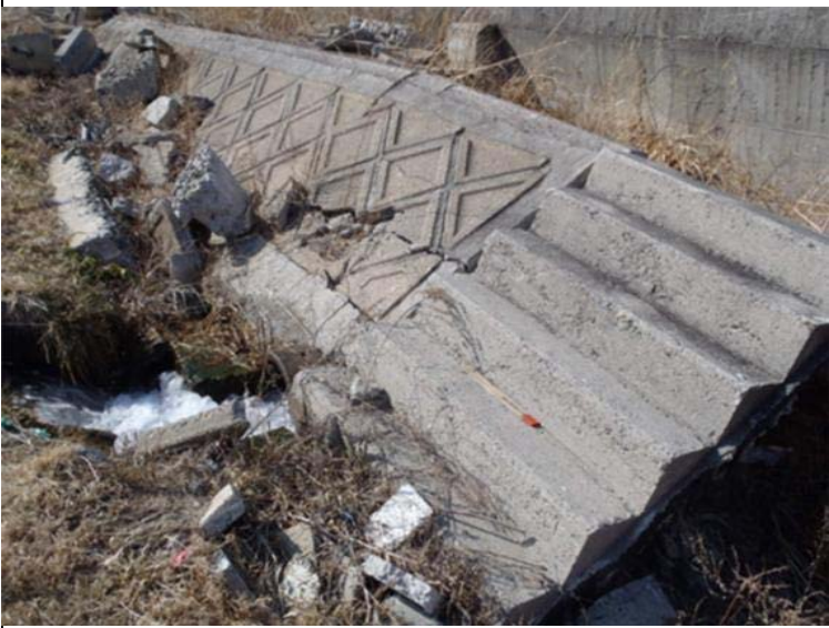
放水口は前回の調査時同様に破損堰堤が塞いでいる
