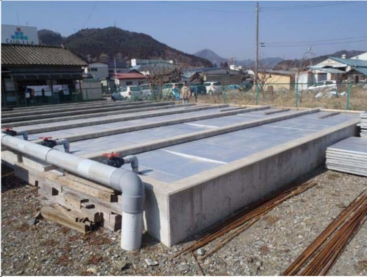
盛川第2ふ化場:養魚池
