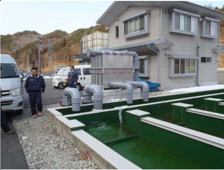
第3施設(B池)壁面塗装済み シルバーの箱は曝気槽
