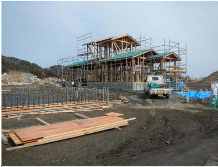
飼育池：配筋、型枠設置中
