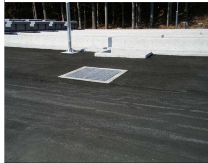
飼育池排水部：排水の勢いが強く、柵に当たり放流稚魚への影響が懸念されるため、改良を助言
