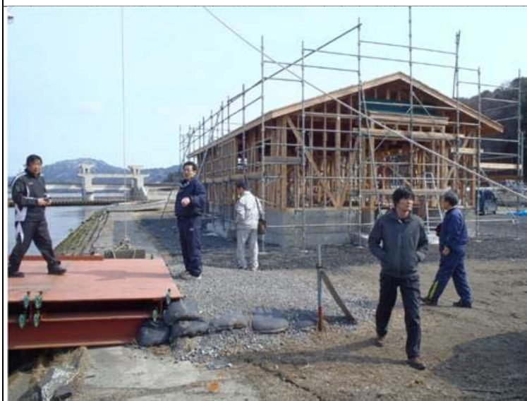
新設採卵施設、施工中
