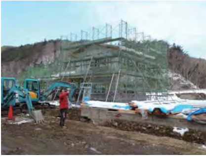
事務室屋根の落雪が飼育池注水部に落下する構造
