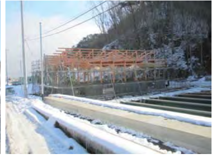
ふ化室屋根の落雪が配水槽送水管に落下する構造
