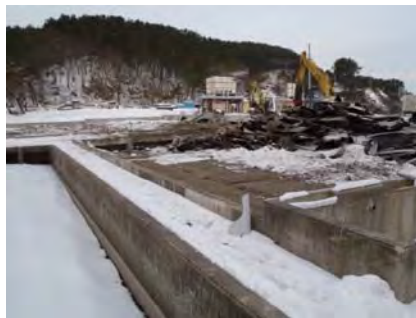
旧施設の撤去工事実施中(蓄養池は、旧施設を活用する方針)
