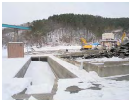
旧施設の撤去工事実施中(蓄養池は、旧施設を活用する方針)
