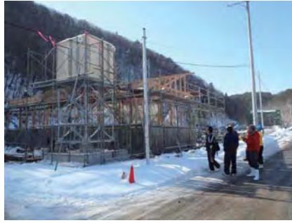
ふ化室屋根の落雪が配水槽送水管に落下する構造
