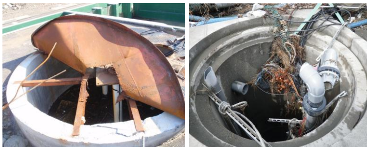
井戸調査は被災ポンプや堆積物の撤去から始めた。
