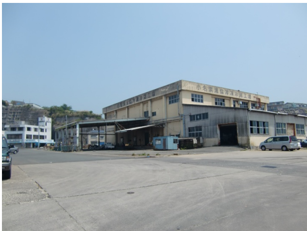
図2.被災した漁協冷凍冷蔵工場
