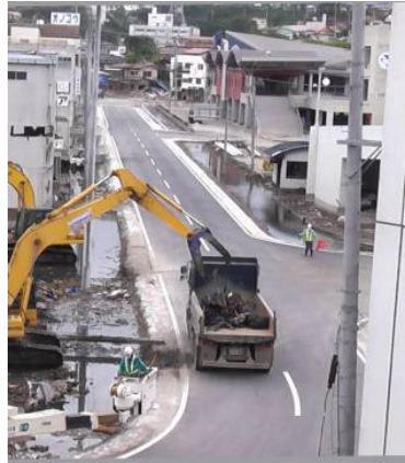
図-2.6.3 いち早く本格復旧した市場周辺の道路（調査場所②）
