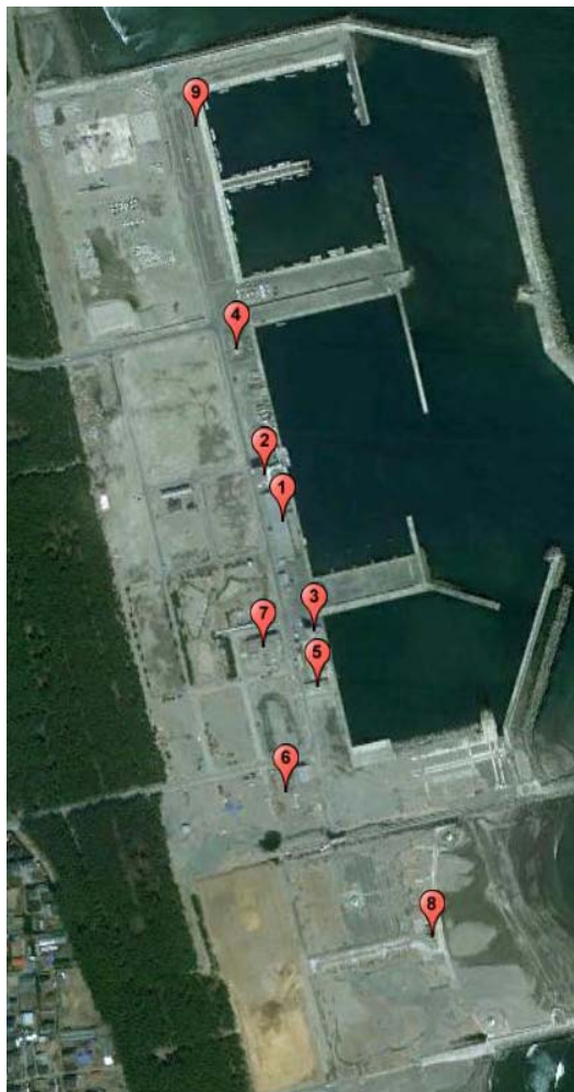
図-2.1.1 水産関連施設調査場所（三沢） ※図内番号は、後述の丸番号に対応。
