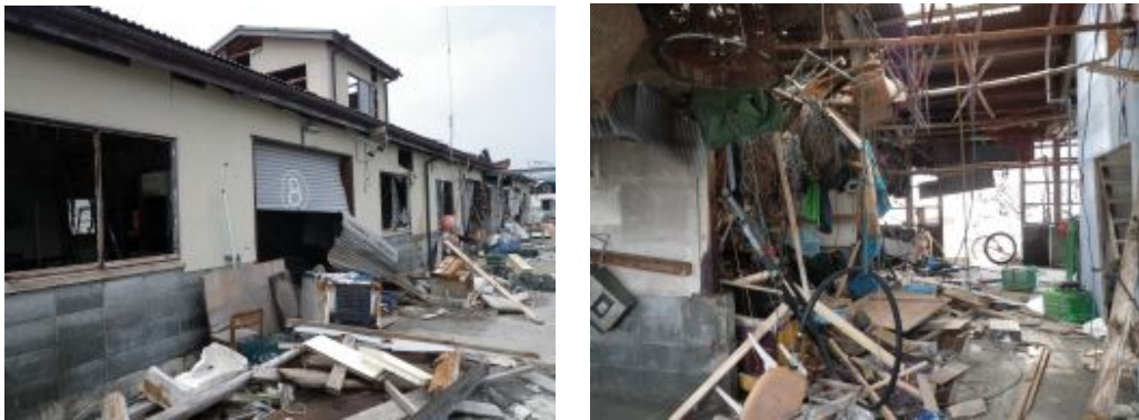
図-2.3.7 養殖作業場の被災状況（調査場所⑤）
