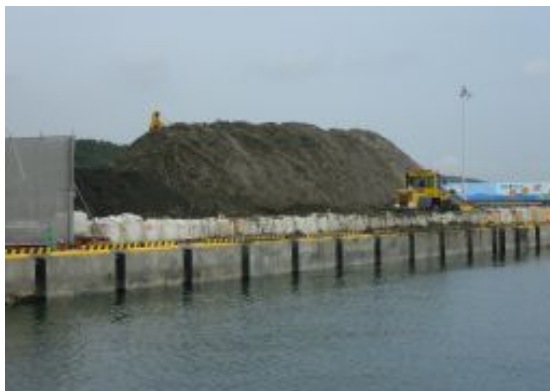
図-2.1.10 浚渫残土の仮置き状況(調査場所⑨)
