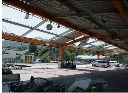
図-2.5.4 細浦地区の荷捌き所（調査場所③）
