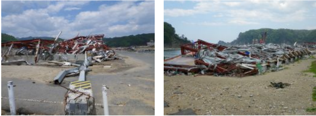
図-2.2.4 水産加工場の被災状況(調査場所③)
