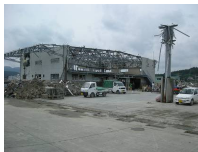
図-2.7.2 魚市場 左：旧市場の痕跡（調査場所①）、 右：被災した新市場（荷さばき所の屋根は撤去済み。調査場所②）
