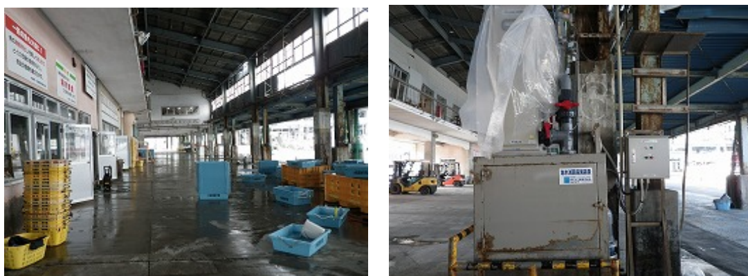
図-2.5.3 魚市場の状況（復旧作業が進んでいた）（調査場所②）
