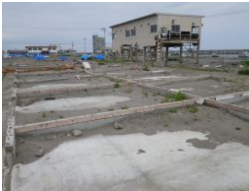
図-2.1.7 漁具保管施設(小型倉庫)の被災状況(調査場所⑥)
