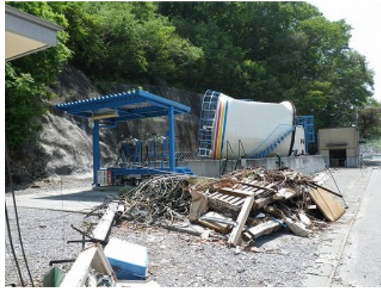
図-2.5.9 給油施設の被災状況（調査場所⑨）
