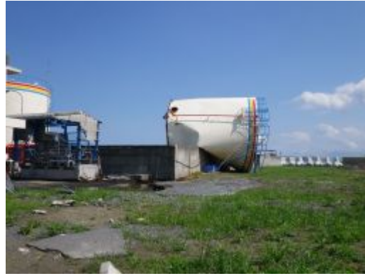
図-2.9.6 流出した給油施設（調査場所⑦）（左：防波堤上に漂着）
