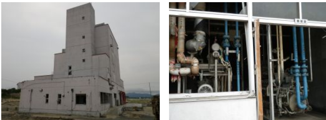
図-2.11.3 製氷施設の被災状況 (調査場所②)
