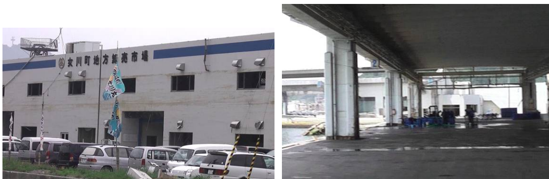
図-2.8.2 女川魚市場（調査場所①）。左：事務棟、右：荷捌き所
