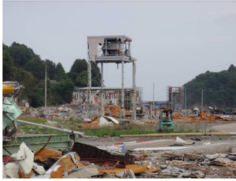
図-2.7.4 漁協の製氷施設の被災状況（調査場所④）
