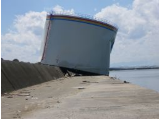
図-2.9.6 流出した給油施設（調査場所⑦）（左：防波堤上に漂着）
