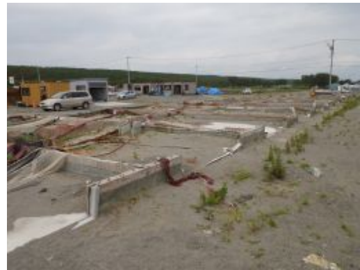
図-2.1.7 漁具保管施設(小型倉庫)の被災状況(調査場所⑥)
