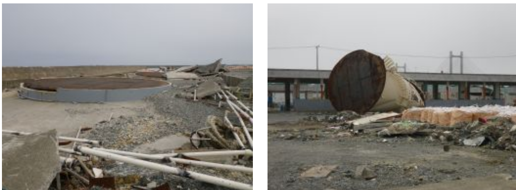
図-2.11.5 給油施設(タンク)の被災状況（調査場所③）
