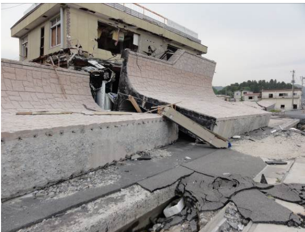
図-2.17 防潮堤中央区間の被災状況
