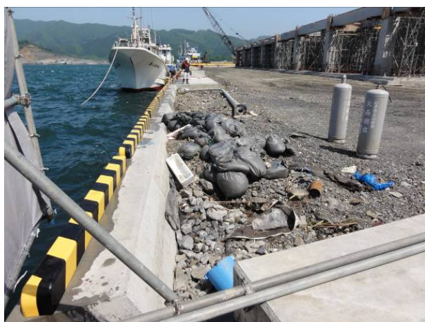
図-4.9 -5.0m 岸壁の被災状況 (左図：エプロンの飛散および洗掘状況、右図：施設法線のずれ)
