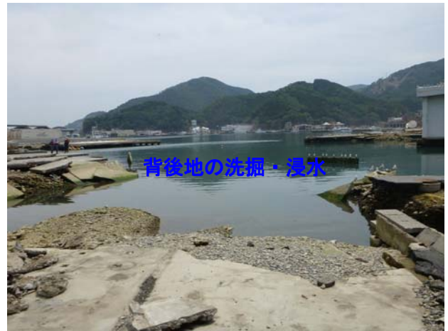
図-7.8 宮ヶ崎取付岸壁・大原岸壁の被災状況 (左図：ラジコンヘリ撮影* 3 )
