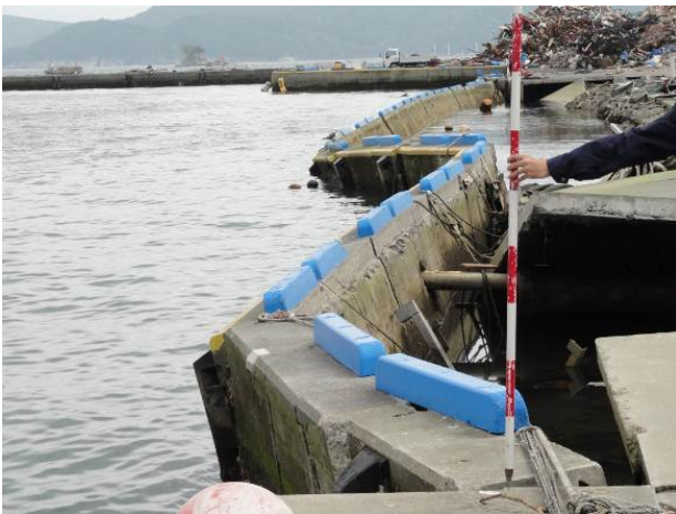
図-3.12 -4.0m 岸壁周辺の被災状況
