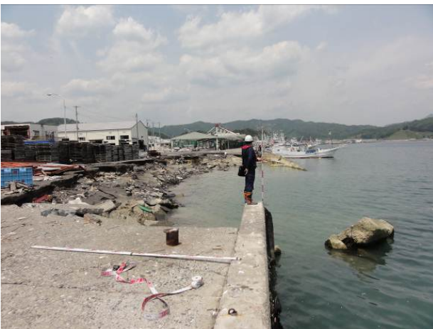
図-2.9 -5.0m 岸壁の被災状況 (上段左図：ラジコンヘリ撮影 *3 )
