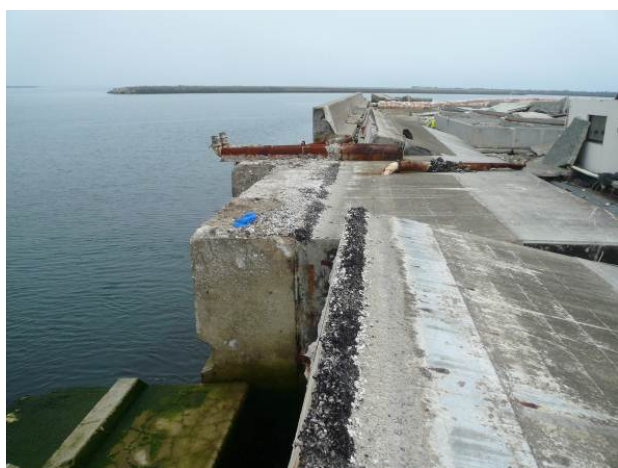
図-10.5 第4護岸周辺の被災状況
