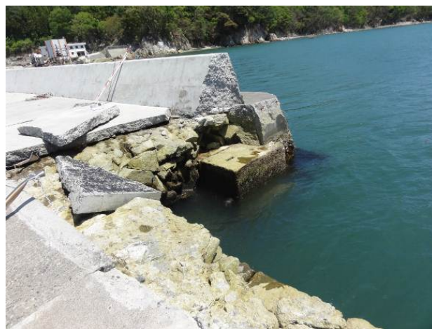
図-3.5 防波堤の被災状況
