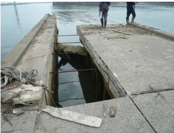
図-10.16 松川浦漁港海岸保全施設（大洲堤防）周辺の被災状況
