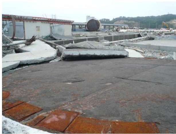
図-10.5 第4護岸周辺の被災状況
