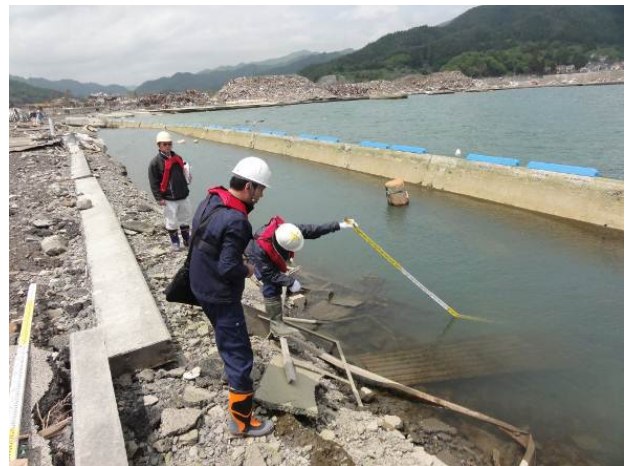
図-3.12 -4.0m 岸壁周辺の被災状況
