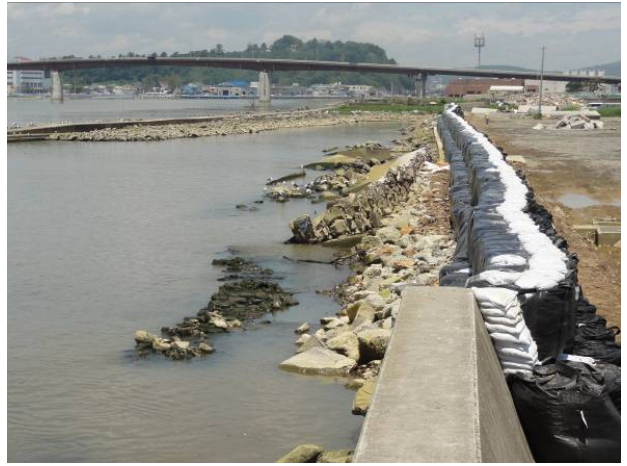
図-8.4 西護岸周辺の被災状況
