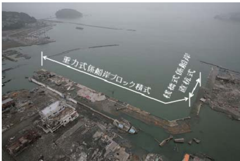
図-6.14 本岸壁（本浜町、南町）の被災状況（ラジコンヘリ撮影* 3 ）
