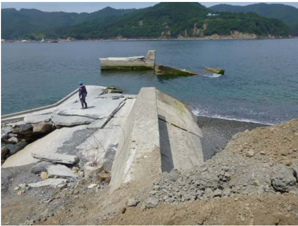
図-7.5 南防波堤の被災状況
