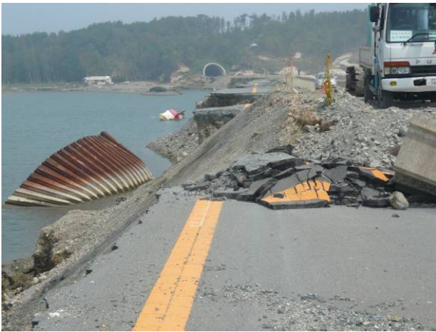
図-10.16 松川浦漁港海岸保全施設（大洲堤防）周辺の被災状況
