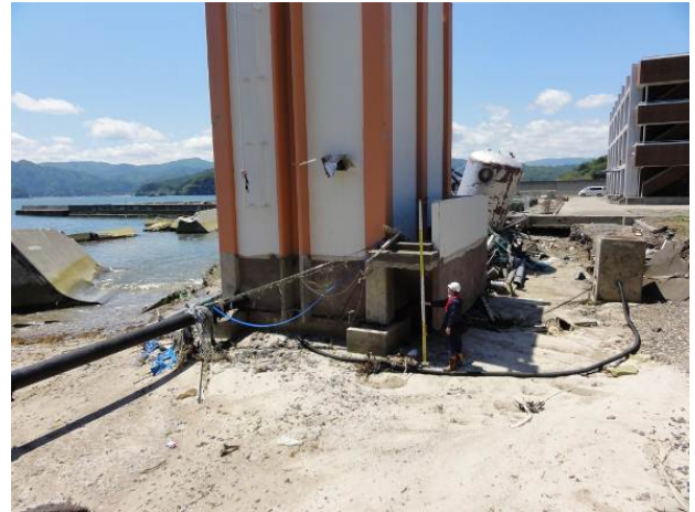
図-3.17 防波堤東区間の被災状況 (上段左図：水門に隣接した隅角部、上段右図・下段左図：東大海洋研前面、 下段右図：東大海洋研防潮堤背後の洗掘状況)
