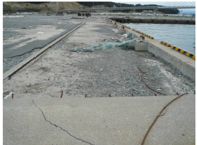
図-10.14 -3.0m 岸壁周辺の被災状況
