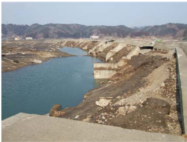
図-1.22 北防潮堤（第1線堤西側）の被災状況 (左図：被災直後(3/13)に撮影写真(岩手県提供))
