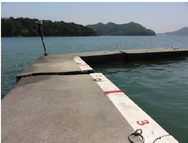
図-4.5 防波堤（大船渡地区）の被災状況
