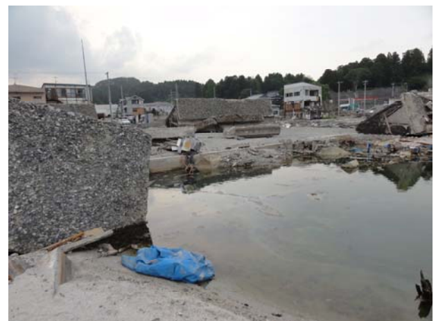
図-2.18 防潮堤北区間の被災状況
