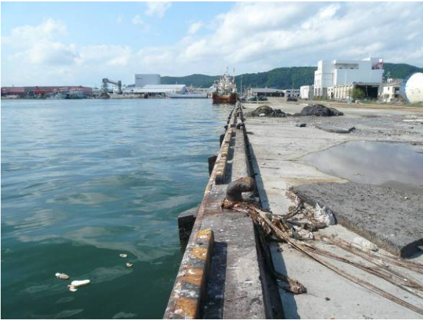
図-8.12 -6.0m 岸壁周辺の被災状況
