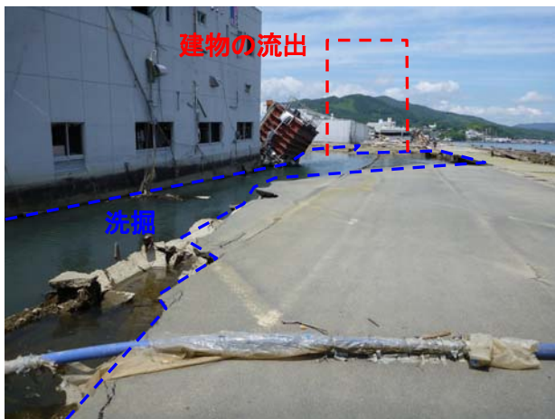
図-5.14 -6.0m 岸壁（魚市場前地区）の被災状況 （上から1段目：ラジコンヘリ撮影*3）
