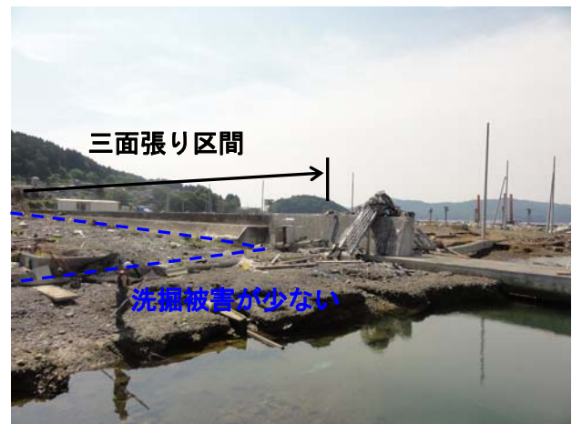
図-6.18 防潮堤付近の被災状況 (上段：ラジコンヘリ撮影* 3 )
