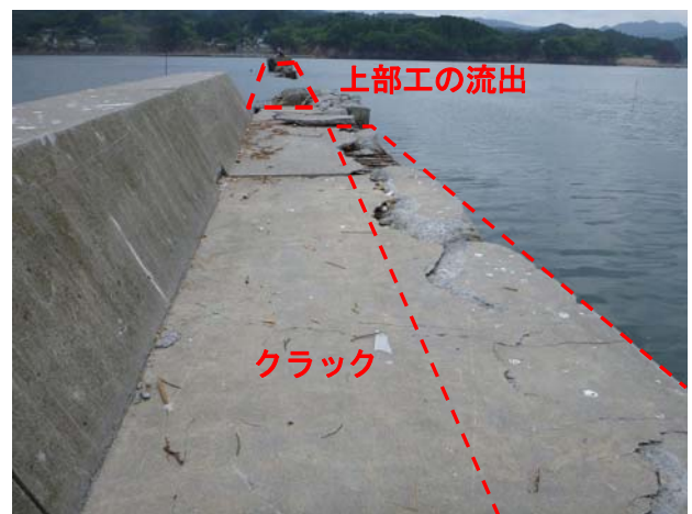
図-6.11 防波堤（大森地区）付近の被災状況 （上段右図：ラジコンヘリ撮影*3）
