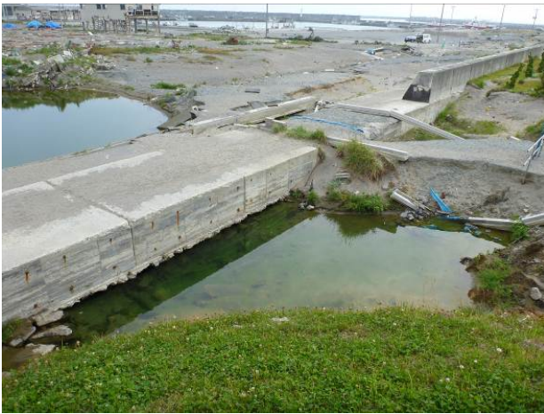
図-11.15 南護岸周辺の被災状況
