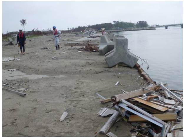
図-9.8 -3.5m 岸壁周辺の被災状況
