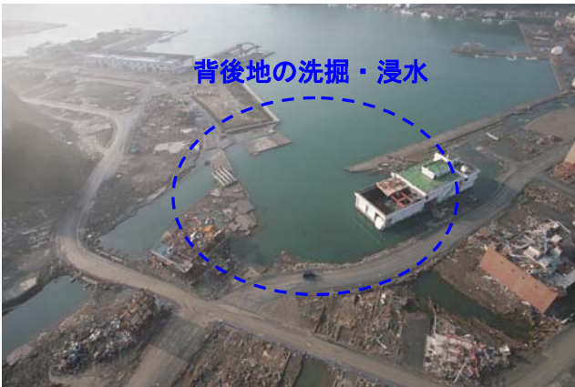
図-7.8 宮ヶ崎取付岸壁・大原岸壁の被災状況 (左図：ラジコンヘリ撮影* 3 )
