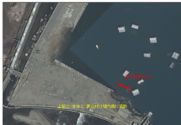
図-1.14 -4.0m 岸壁（ブロック積式）の被災状況
