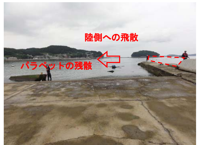
図-6.8 南防波堤の被災状況
