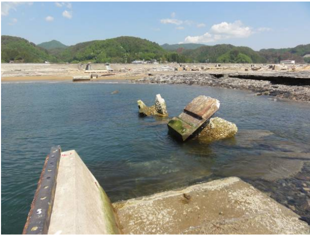
図-1.16 -4.0m岸壁（直立消波ブロック式）の被災状況 （左図：漁港南の北隅角部西側岸壁、右図：南隅角部西側岸壁）
