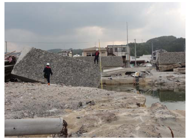
図-2.17 防潮堤中央区間の被災状況
