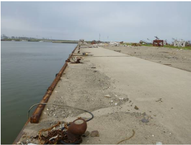
図-9.8 -3.5m 岸壁周辺の被災状況
