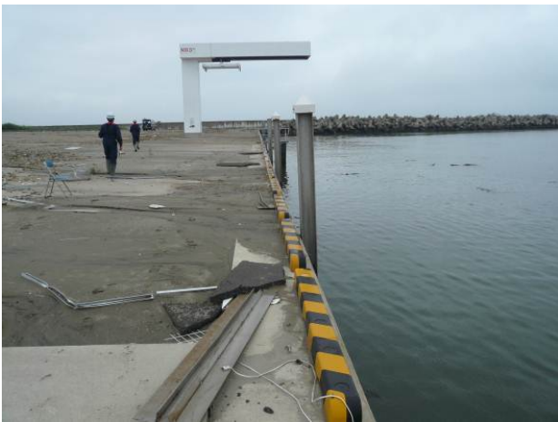
図-9.10 -3.0m 岸壁周辺の被災状況
