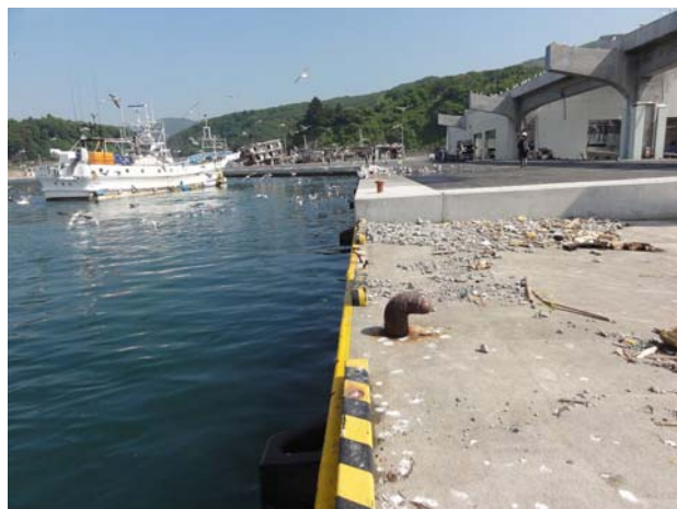
図-7.11 -5.5m 岸壁付近の被災状況 (上から1段目：市場前の状況、2段目・3段目：荷捌場付近の状況)
