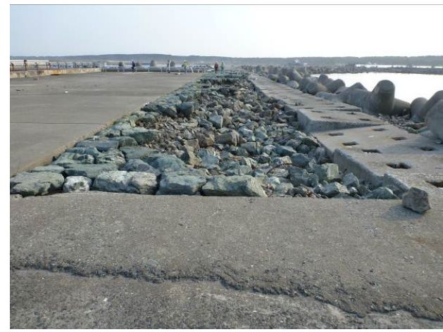
図-11.10 外南防波堤周辺の被災状況
