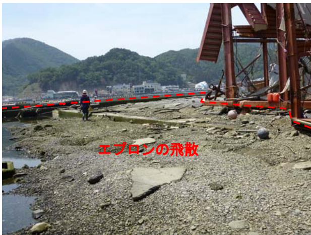
図-7.13 -7.0m 岸壁の被災状況
