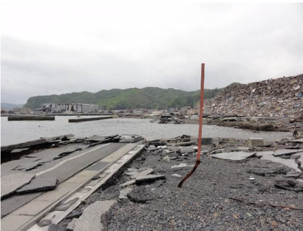
図-3.10 船揚場周辺の被災状況 (下段右図：被災後の衛星写真* 2 )
