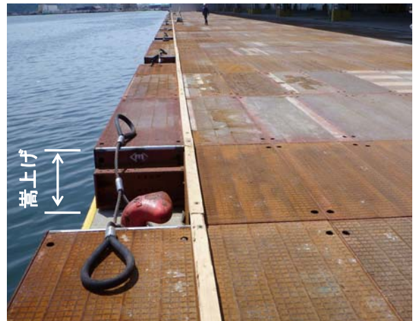
図-5.6 -6.0m岸壁（魚市場前地区、地盤改良有り）の復旧状況
