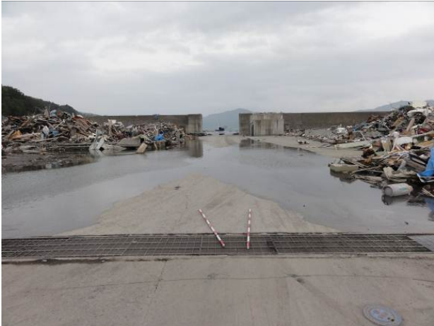
図-3.16 防波堤西区間の被災状況 (上から1段目・2段目・3段目左図：船揚場背後周辺、 3断面右図：山付き部周辺、4段目：陸閘周辺における門扉の飛散および前面の洗掘)
