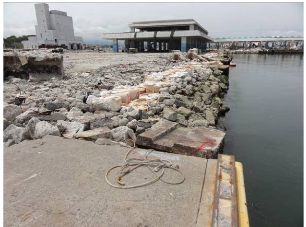
图-10.13 -3.0m 第4岸壁周辺の被災状況
