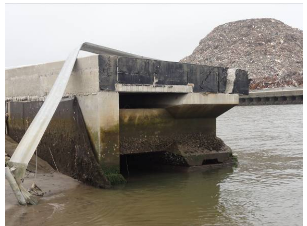
図-9.5 A 護岸周辺の被災状況
