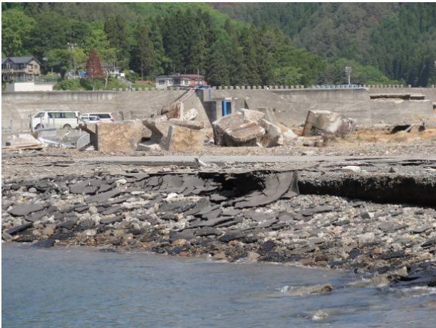
図-1.18 直立消波ブロックの飛散状況 （左図：Ⅲ区間背後、右図：Ⅱ・Ⅲ区間上空から）
