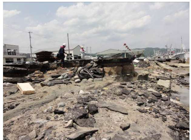
図-2.9 -5.0m 岸壁の被災状況 (上段左図：ラジコンヘリ撮影 *3 )
