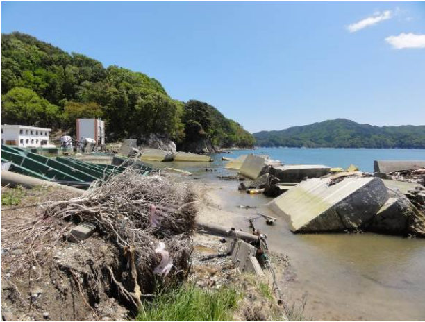
図-3.17 防波堤東区間の被災状況 (上段左図：水門に隣接した隅角部、上段右図・下段左図：東大海洋研前面、 下段右図：東大海洋研防潮堤背後の洗掘状況)
