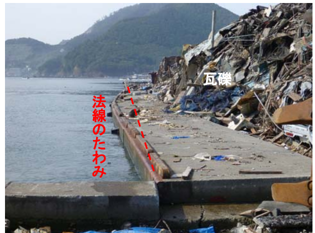
図-7.13 -7.0m 岸壁の被災状況
