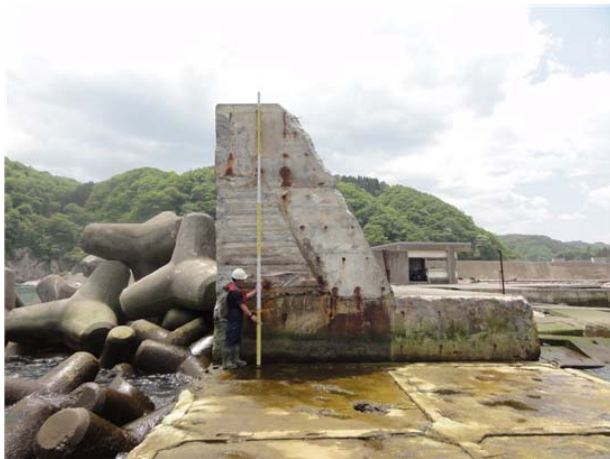
図-1.8 防波堤周辺の被災状況
