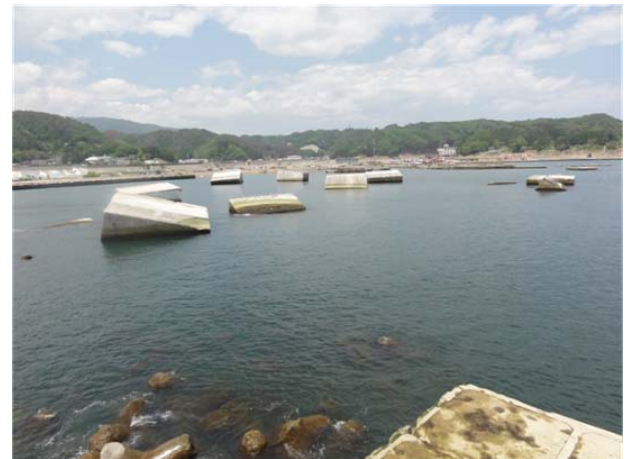
図-1.8 防波堤周辺の被災状況
