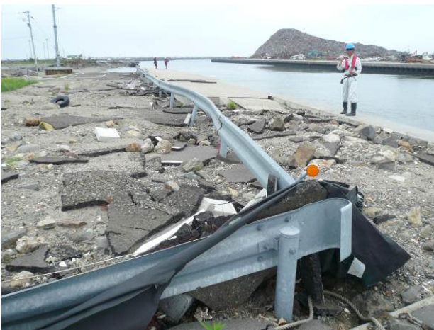
図-9.5 A 護岸周辺の被災状況
