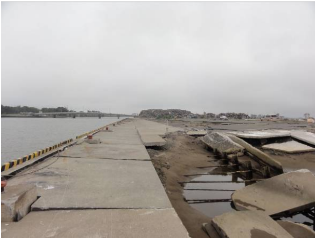
図-9.6 魚市場前-3.5m 岸壁周辺の被災状況
