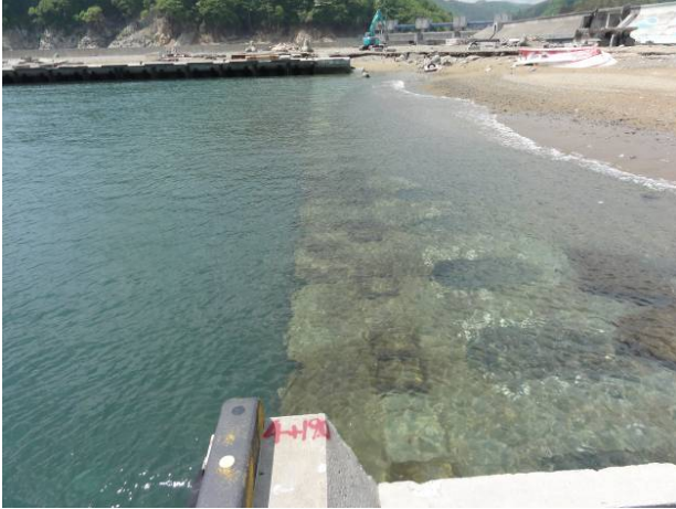
図-1.16 -4.0m岸壁（直立消波ブロック式）の被災状況 （左図：漁港南の北隅角部西側岸壁、右図：南隅角部西側岸壁）
