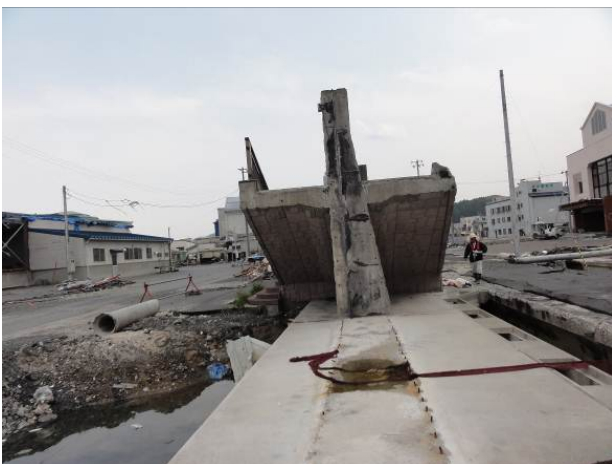
図-2.18 防潮堤北区間の被災状況
