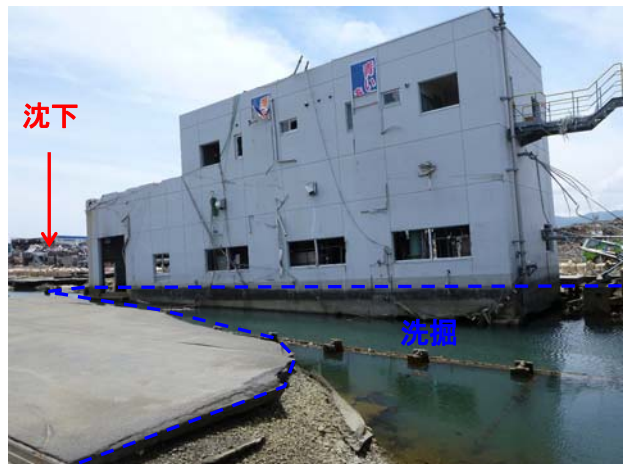
図-5.14 -6.0m 岸壁（魚市場前地区）の被災状況 （上から1段目：ラジコンヘリ撮影*3）
