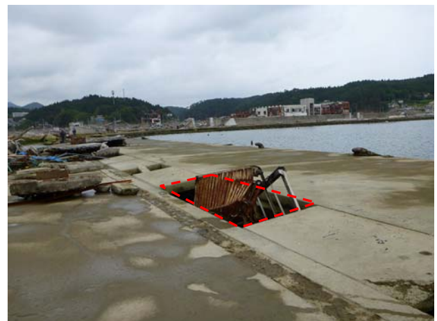
図-6.16 本岸壁（本浜町、南町）栈橋式区間の被災状況 （上段：ラジコンヘリ撮影 *3 ）
