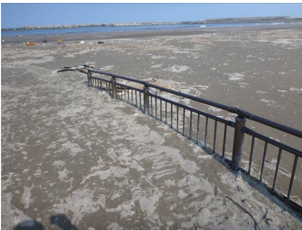
図-11.15 南護岸周辺の被災状況
