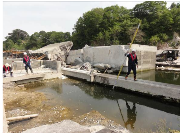
図-2.16 防潮堤南区間の被災状況 (上から1段目左図：ラジコンヘリ撮影* 3 )
