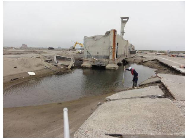
図-9.6 魚市場前-3.5m 岸壁周辺の被災状況
