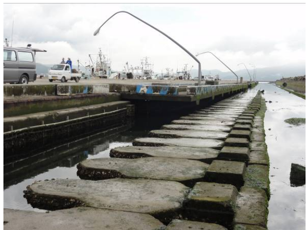
図-8.11 西防波堤（I区）背後の-7.0m岸壁周辺の被災状況
