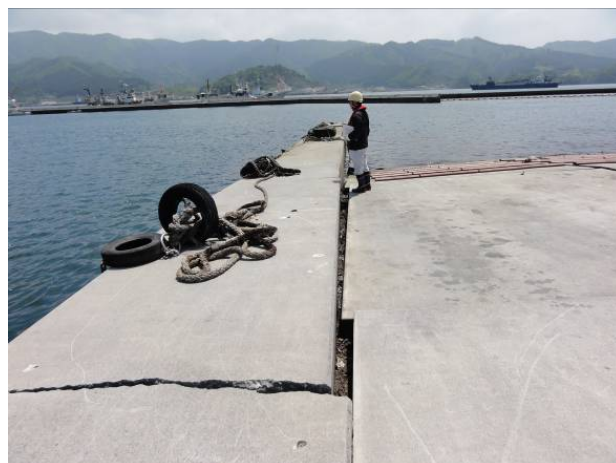
図-4.7 -2.0m 物揚場周辺の被災状況 (左図：物揚場の沈下、右図：隣接する船揚場突堤のひび割れ)
