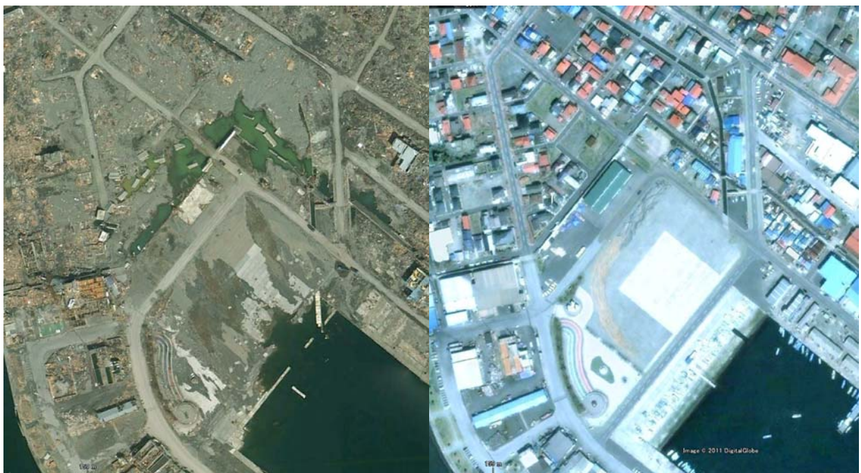
図-3.15 船揚場周辺の被災前後の状況*2 (左図：被災後、右図：被災前)
