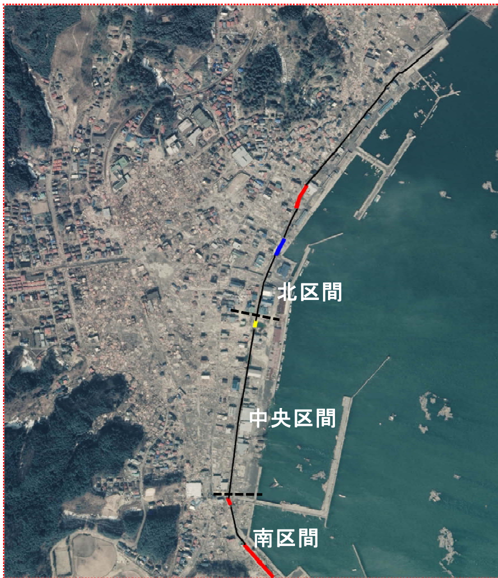
図-2.15 防潮堤の被災箇所 (赤線：台形断面重力式、黄線：矩形断面擁壁部、青線：テラス式)
