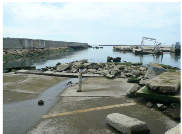
図-8.6 用地護岸周辺の被災状況
