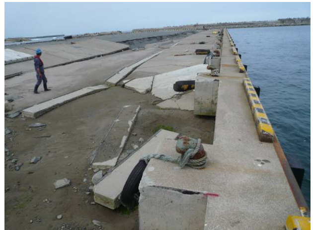
図-10.14 -3.0m 岸壁周辺の被災状況
