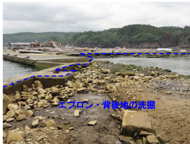
図-6.15 本岸壁（本浜町、南町）ブロック積式区間の被災状況
