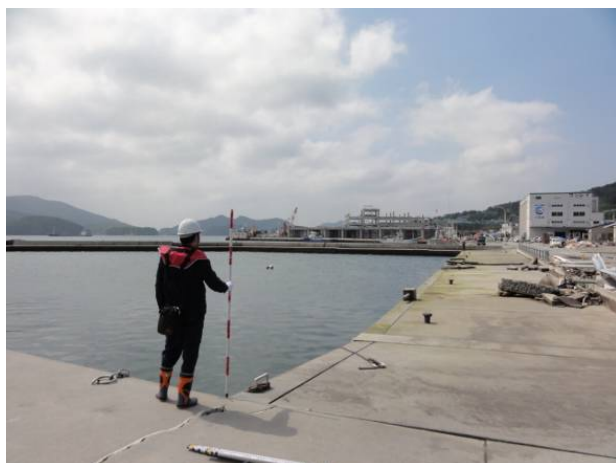
図-4.7 -2.0m 物揚場周辺の被災状況 (左図：物揚場の沈下、右図：隣接する船揚場突堤のひび割れ)
