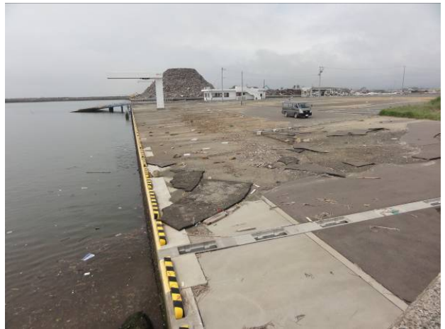
図-9.10 -3.0m 岸壁周辺の被災状況
