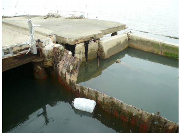
図-10.16 松川浦漁港海岸保全施設（大洲堤防）周辺の被災状況
