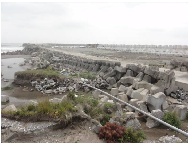
図-11.8 北護岸周辺の被災状況
