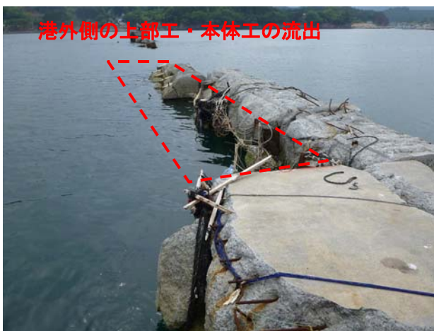
図-6.11 防波堤（大森地区）付近の被災状況 （上段右図：ラジコンヘリ撮影*3）
