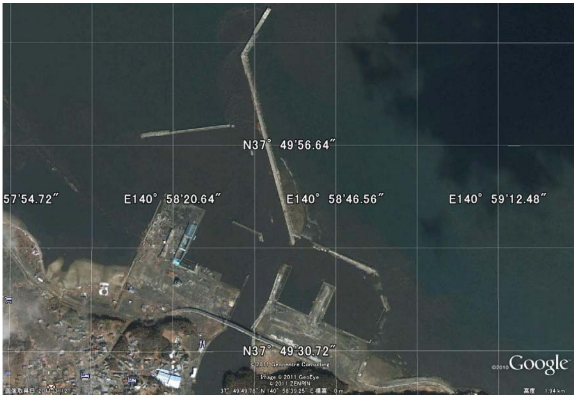
図-10.2 被災前後の松川浦漁港（上段：被災前、下段：被災後）*2
