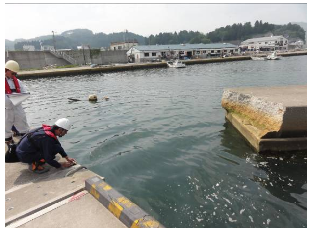
図-2.7 南第1防波堤隣接護岸（左図）および内港防波堤（右図）の被災状況
