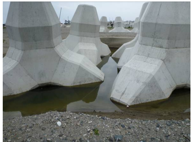
図-11.8 北護岸周辺の被災状況
