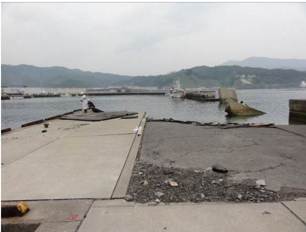
図-2.13 -2.0m 物揚場の被災状況 (上段左図：ラジコンヘリ撮影* 3 )
