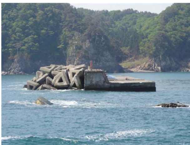
図-1.11 沖防波堤周辺の状況
