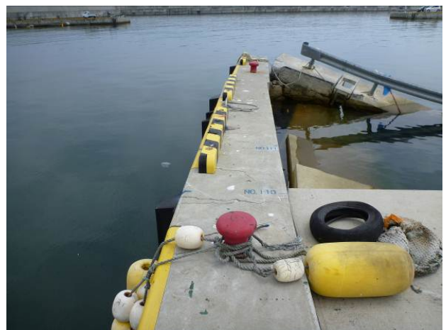
図-11.14 -4.0m岸壁（用地護岸）周辺の被災状況
