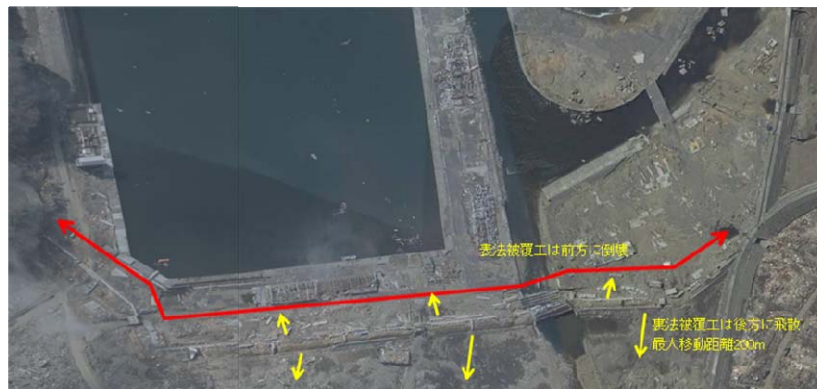
図-1.20 北防潮堤（第1線堤東側）の被災状況 (上から1段目：被災直後(3/13)に撮影写真(岩手県提供))
