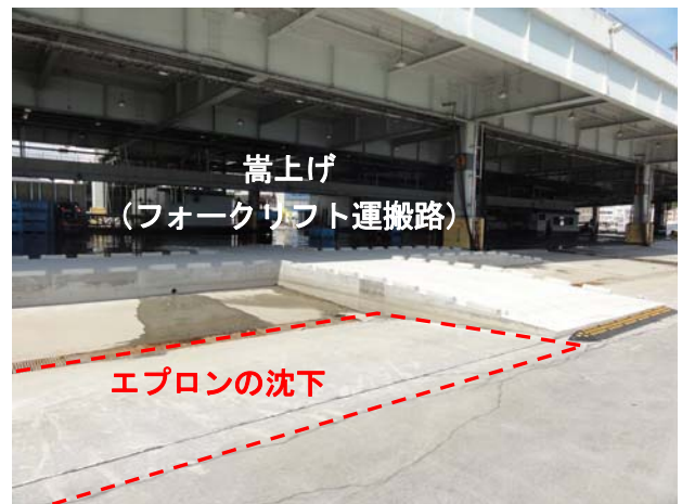
図-5.10 -6.0m岸壁（魚市場前）の被災状況
