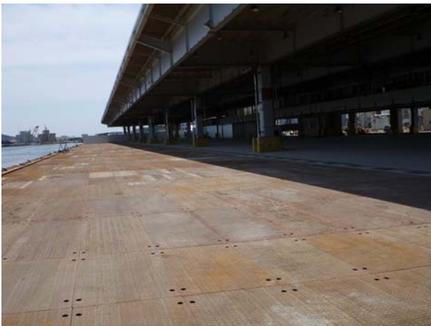
図-5.6 -6.0m岸壁（魚市場前地区、地盤改良有り）の復旧状況
