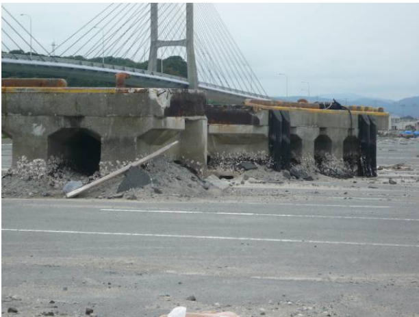
図-10.14 -3.0m 岸壁周辺の被災状況
