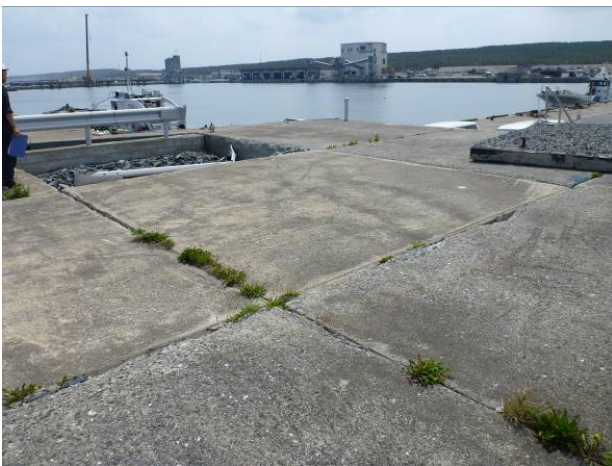
図-11.5 中防波堤周辺の被災状況
