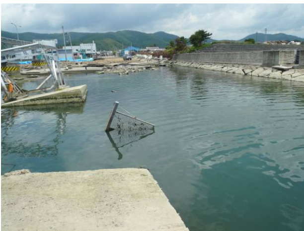
図-8.6 用地護岸周辺の被災状況
