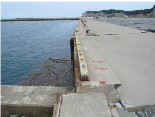
図-10.15 -4.0m 岸壁周辺の被災状況
