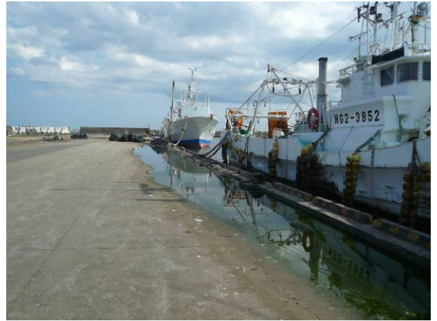
図-8.12 -6.0m 岸壁周辺の被災状況
