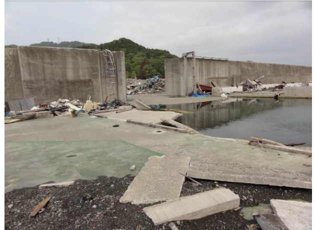
図-3.16 防波堤西区間の被災状況 (上から1段目・2段目・3段目左図：船揚場背後周辺、 3断面右図：山付き部周辺、4段目：陸閘周辺における門扉の飛散および前面の洗掘)
