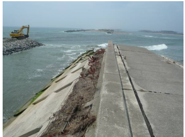
図-10.16 松川浦漁港海岸保全施設（大洲堤防）周辺の被災状況
