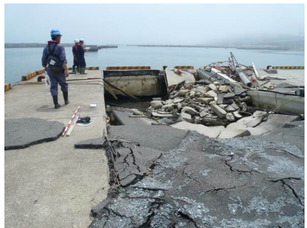
图-10.11 -4.0m 岸壁周辺の被災状況
