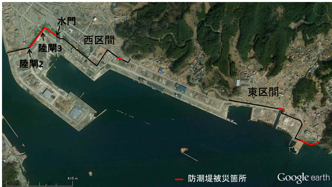
図-3.14 大槌漁港背後の防潮堤位置とその被災区間*2
