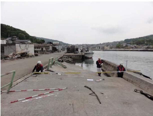
図-4.13 -3.0m 岸壁（細浦地区）の被災状況
