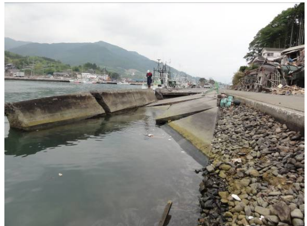
図-4.13 -3.0m 岸壁（細浦地区）の被災状況
