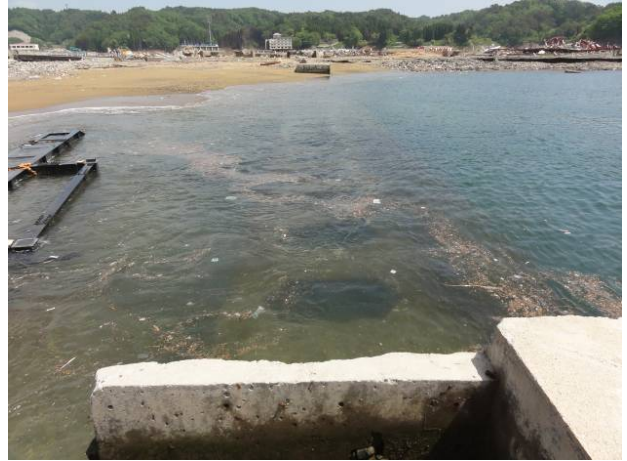
図-1.16 -4.0m岸壁（直立消波ブロック式）の被災状況 （左図：漁港南の北隅角部西側岸壁、右図：南隅角部西側岸壁）
