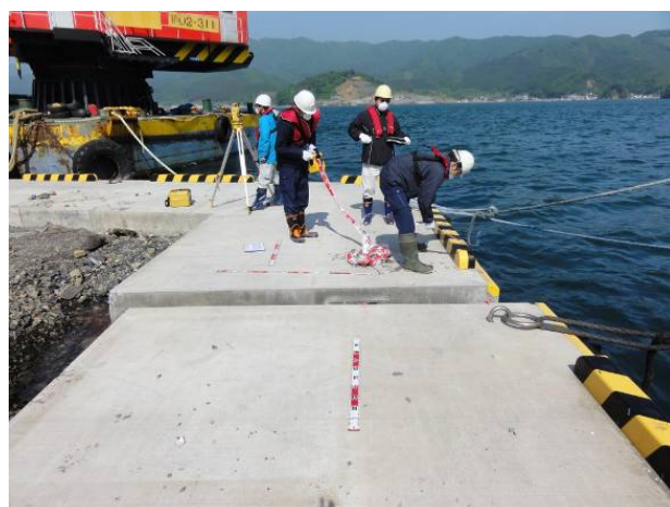
図-4.9 -5.0m 岸壁の被災状況 (左図：エプロンの飛散および洗掘状況、右図：施設法線のずれ)
