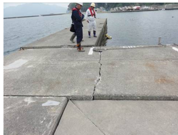
図-2.5 南第1防波堤などの被災状況 (上段左図：ラジコンヘリ撮影* 3 、下段右図：テラス型防潮堤前の防波堤)
