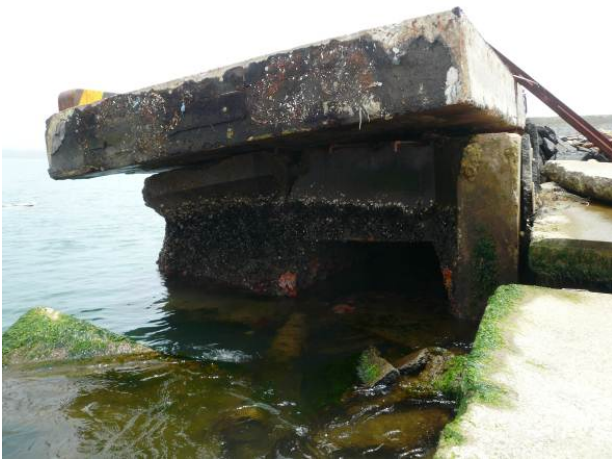
图-10.11 -4.0m 岸壁周辺の被災状況
