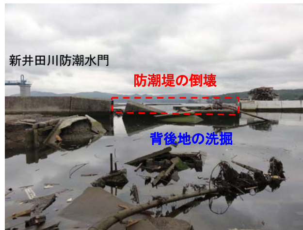
図-6.5 東防波堤付近の被災状況 (上段左図：ラジコンヘリ撮影* 3 )
