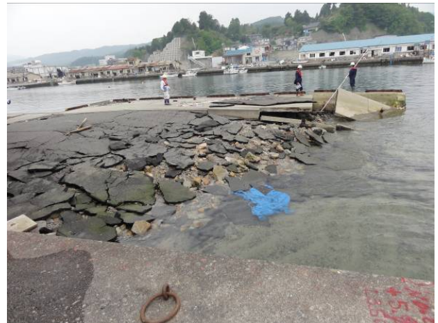
図-2.13 -2.0m 物揚場の被災状況 (上段左図：ラジコンヘリ撮影* 3 )
