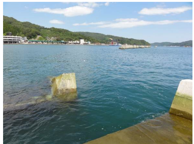
図-3.8 南防波堤基部付近の被災状況
