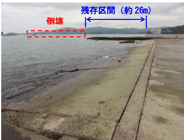
図-6.8 南防波堤の被災状況
