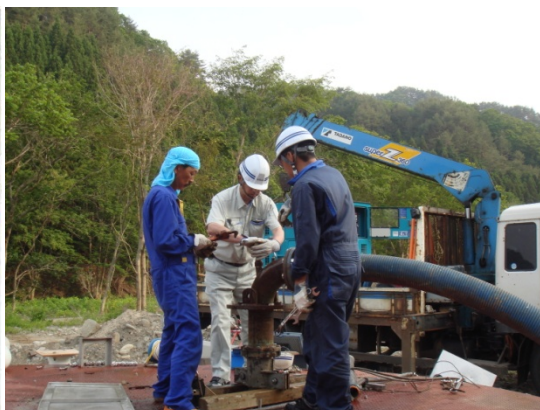
揚水量調査(岩手県野田村の下安家ふ化場)
