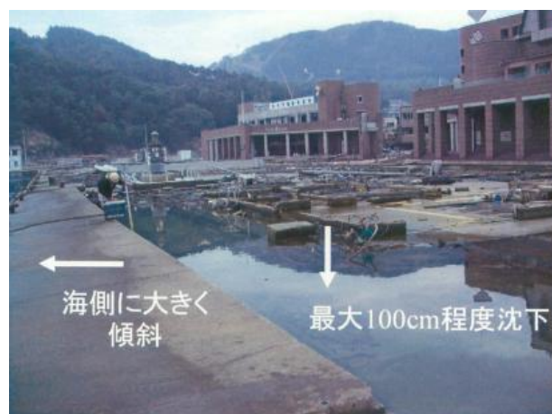
宮城県女川漁港の矢板式岸壁。海側へ傾斜し、背後に大きな沈下が生じました。
