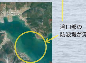
写真、女川湾口部防波堤 (写真提供: 国土地理院)
