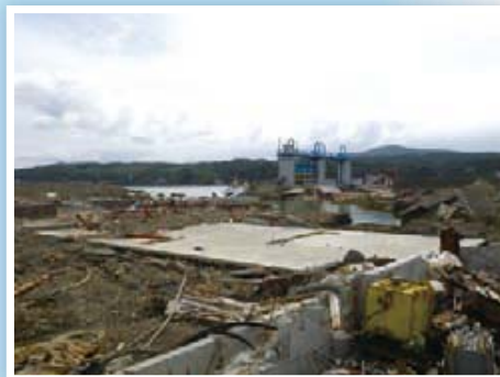
写真1. 壊滅的な被害を受けた南三陸町造船所
