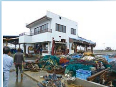
大破した巨理町の漁業協同組合の建屋
