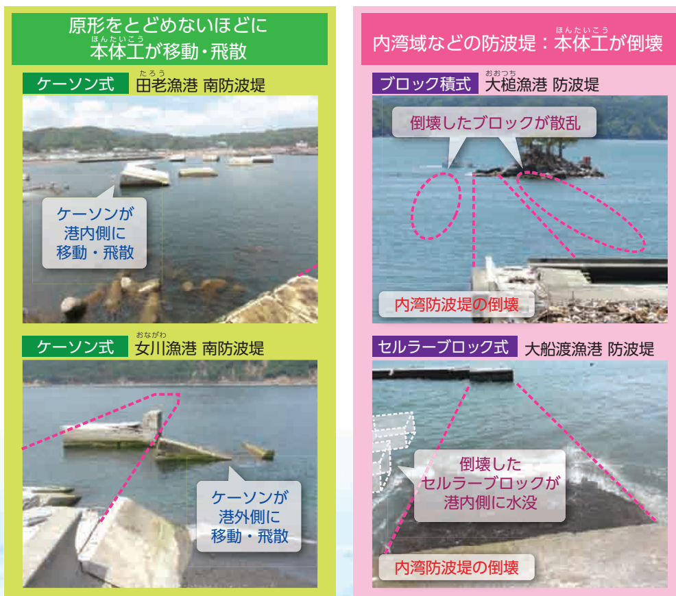
図1. 防波堤の被災事例
