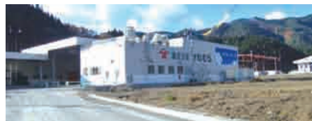
写真1. 再建工事中の秋サケ加工場(陸前高田市)
