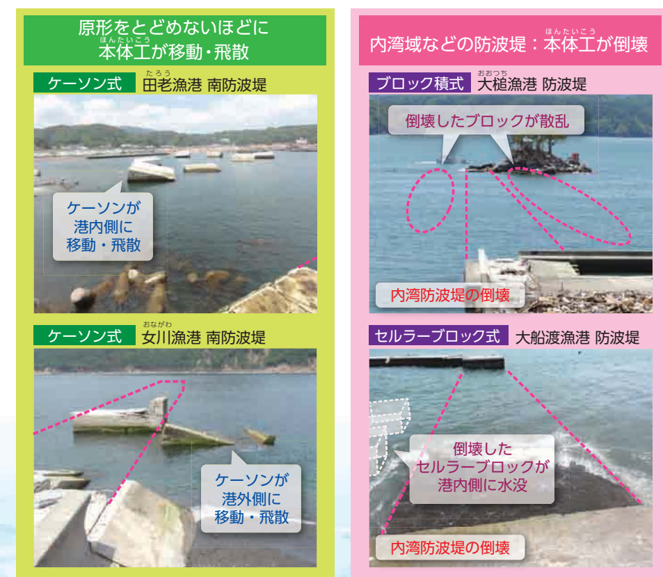
図1. 防波堤の被災事例
