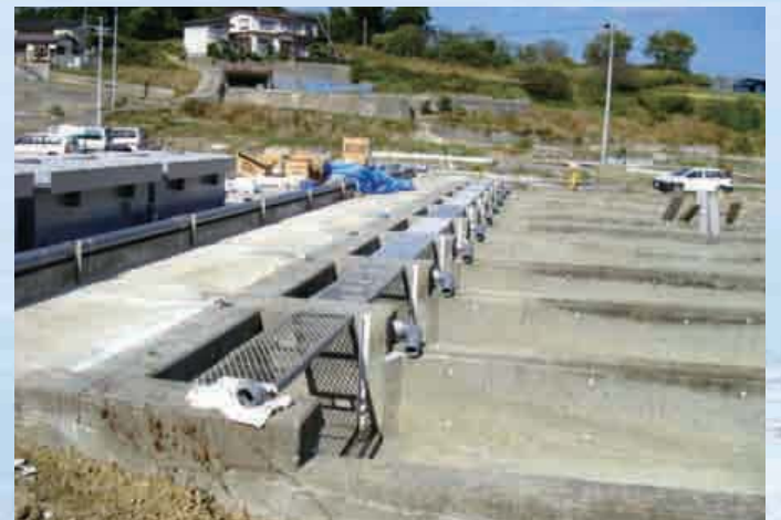
復旧中のふ化施設：水尻川ふ化場 (宮城県南三陸町第二ふ化場)
