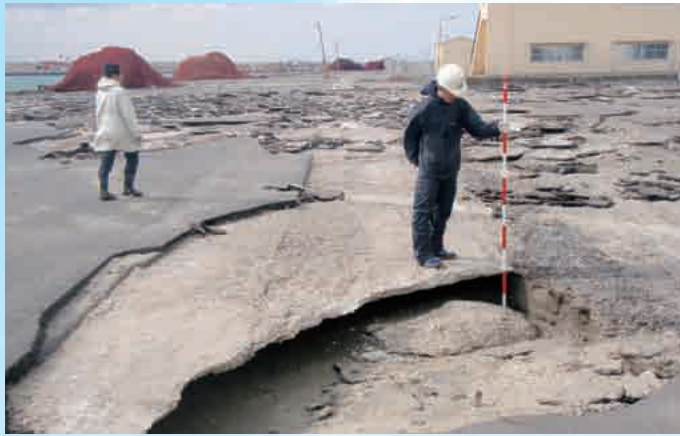
写真1. 3月14日に撮影した漁港・漁港周辺施設の被災状況把握調査の様子
