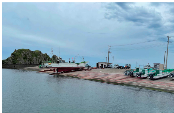
写真1 漁港の斜路式船揚場
