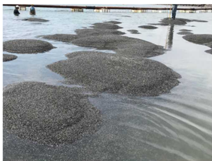
図1 三河湾衣崎地区に敷設された砕石（粒径2.5~5mm程度）
