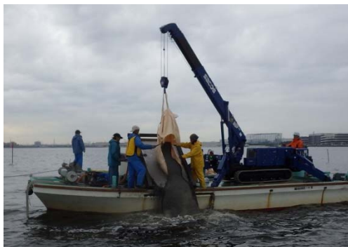
図 1 砕石(上図)とアサリ漁場で実施された砕石散布(下図)
