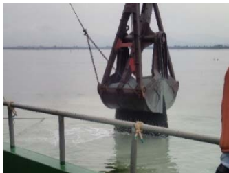
図 1 砕石によるアサリ漁場造成の様子
