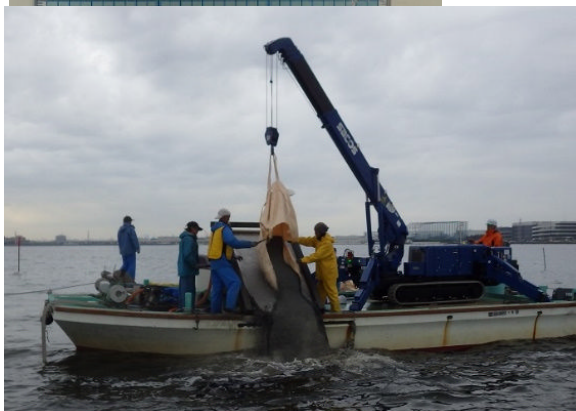
図1 砕石(上)と漁業者による砕石散布(下)
