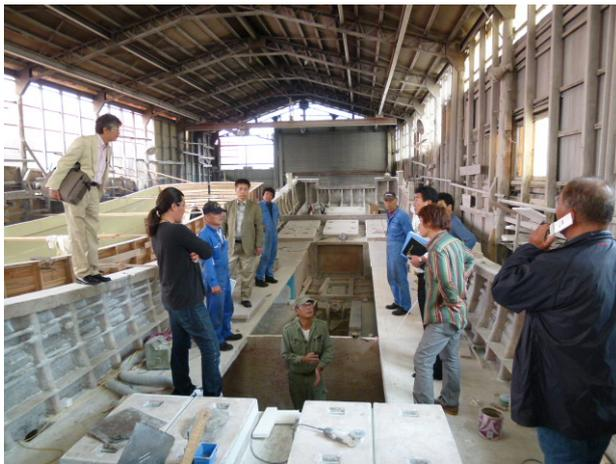
船主、造船所、関連全業者立ち会いの下、建造が進む宮城県向け 9.7 トン型小型底曳き網漁船(千葉県)
