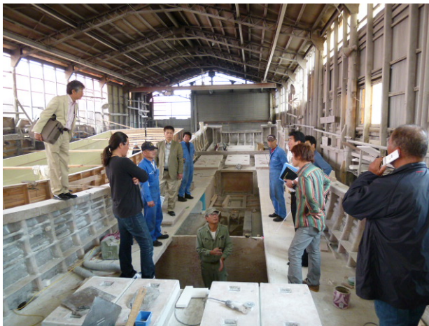
船主、造船所、関連全業者立ち会いの下、建造が進む宮城県向け 9.7 トン型小型底曳き網漁船(千葉県)
