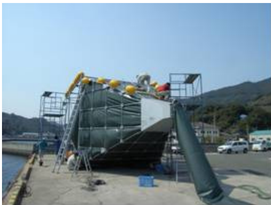
写真1 移動式生簀の製作状況 ↑
