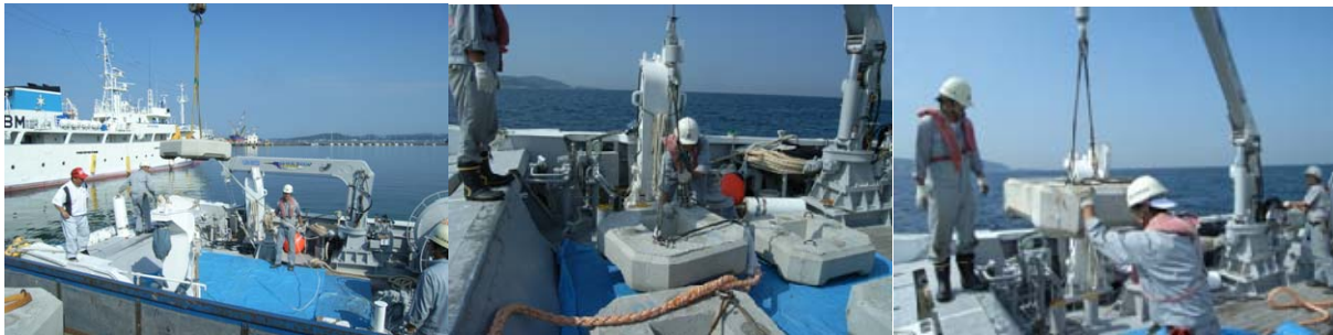
ブロックの積み込み
