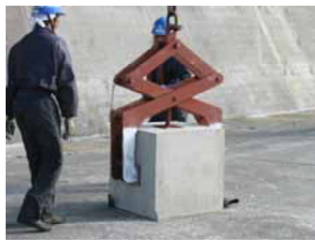
固化体ブロックの製作・設置
