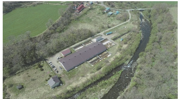
図 5. 渡島管内さけ・ます増殖事業協会遊楽部ふ化場
