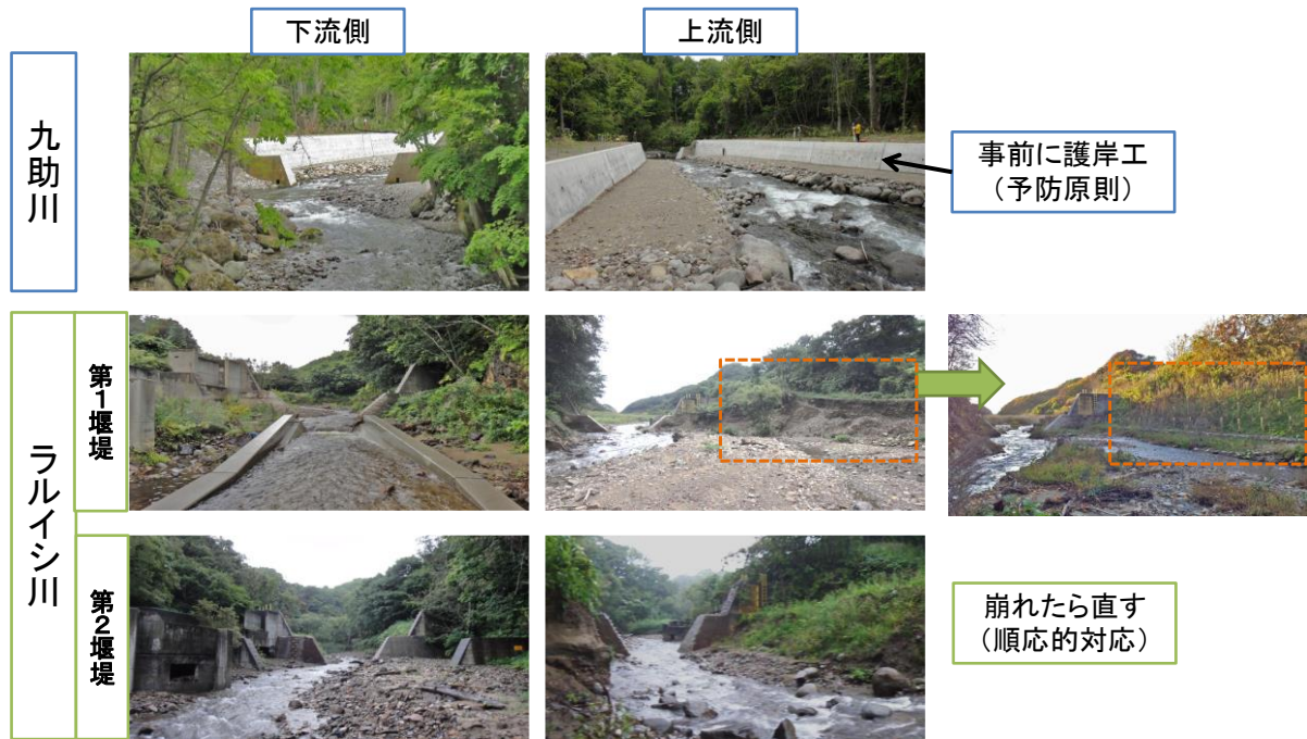
図2. 九助川とラルイシ川での治山ダムのスリット化と治水対策.
