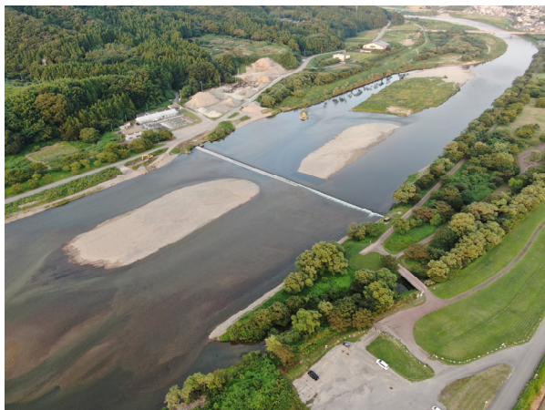
図1. 三面川(手前が下流、中央の下側が種川の入口)。
