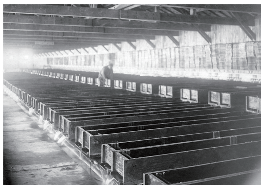
図11. 孵化室内に設置された孵化槽(⑨の写真).
