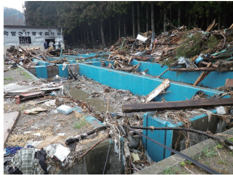
写真 3. 宮城県南三陸町ふ化場小森施設 震災後(ふ化室のみ仮復旧)。
