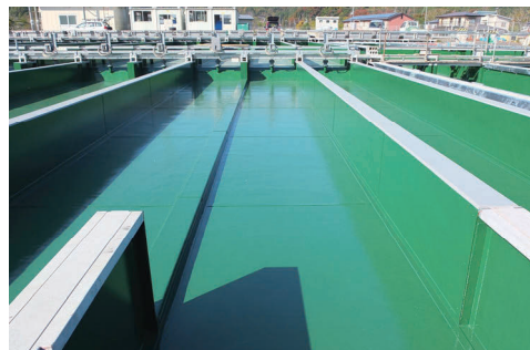
写真 2. 岩手県津軽石ふ化場 アルミ製飼育池を仮復旧し使用していたが、津波時の塩分により腐食が発生、コンクリート製で復旧。
