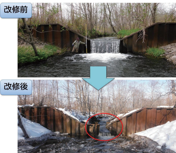
図6. ポー川の落差工の改修。落差工をスリット化した(上:改修前, 下:改修後)。
