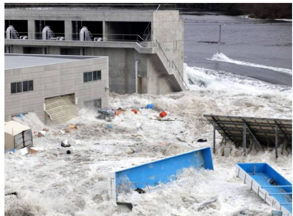
図 1. 岩手県水産技術センターに押し寄せた津波。
