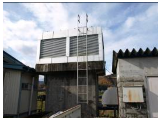
図1. 曝気槽全景。通常、この内部には空気との接触面積を広くするため基材が収められている。
