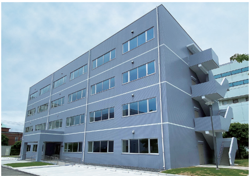
2020年6月に完成した横浜庁舎敷地内の資源研究棟
