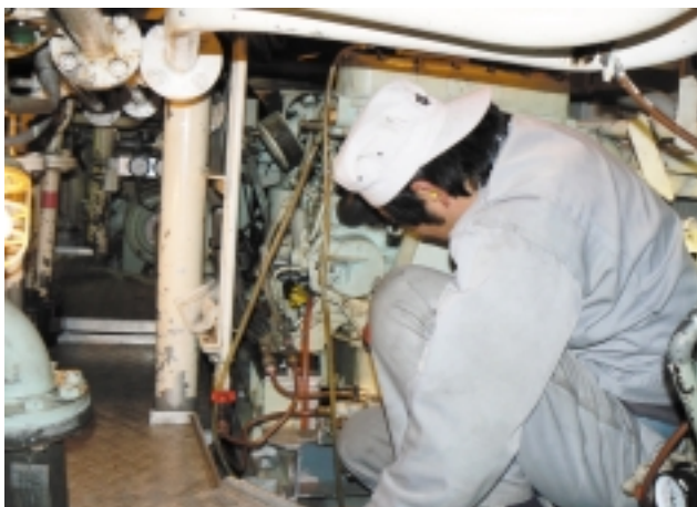
狭い機関室でメンテナンスをする機関長
