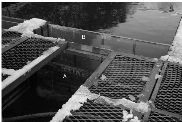
写真1. 飼育池の排水部の構造 A：水位調整用堰板，B 稚魚の流下防止用網 一斉放流の際は A，B 双方を取去り，自然放流の場合は B のみを取去る
