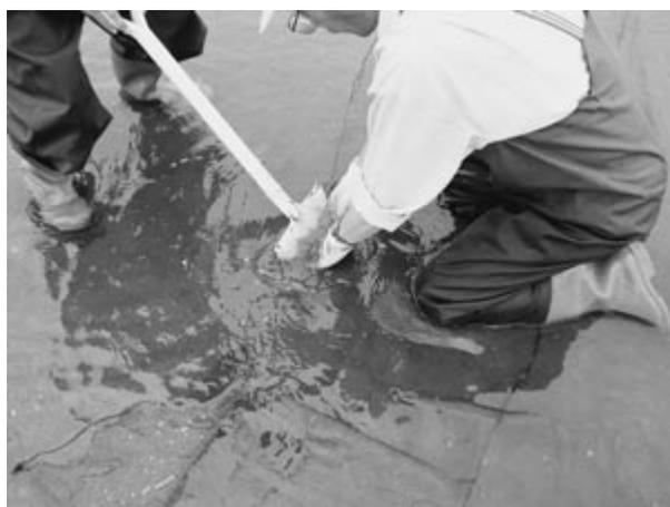
写真2. 被覆網縁辺部埋設詳細：埋設は2人1組で実施。2人がショベルを被覆網の辺に沿って海底面に差し込み、もう2人がショベルに沿って網（50cm程度）を埋め込み、ショベルを海底面から引き抜くことで海底面から15～20cm埋設する。
