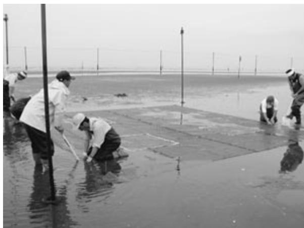
写真1. 被覆網設置：ショベルを使用して縁辺部を埋設
