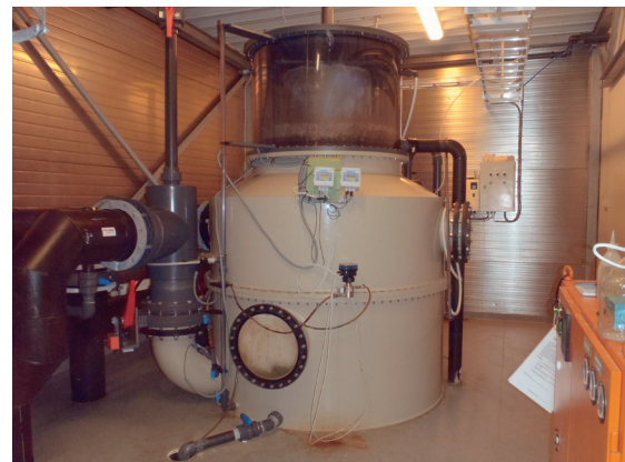
写真2. ノルウェーの Nofima marin 研究所での大西洋マダラ親魚養成システムの一部の大型泡沫分離装置
