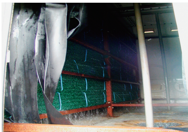
写真1. 代表的な従来型の曝気槽。内部には水を細かな水滴にするための資材が積み重ねられている(写真左は外観、右は内部)
