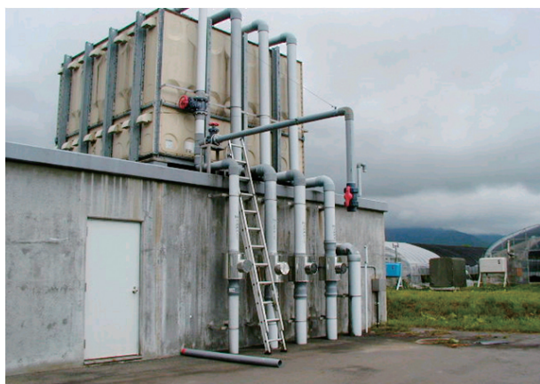
写真1. 代表的な従来型の曝気槽。内部には水を細かな水滴にするための資材が積み重ねられている(写真左は外観、右は内部)
