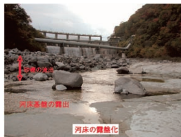
写真1. 河床の露盤化
