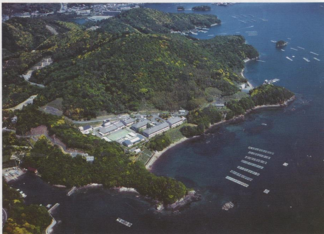
養殖研究所南勢庁舎全景(平成11年5月)
