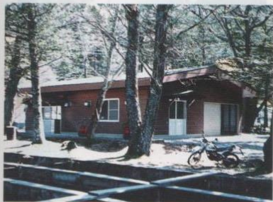
図1. 完成した新飼料調製棟
