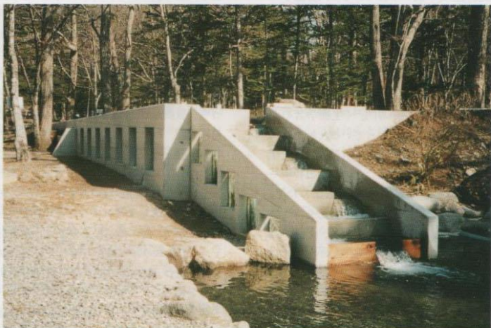
図3. 養殖研日光支所の観覧用を兼ねた実験用魚梯
