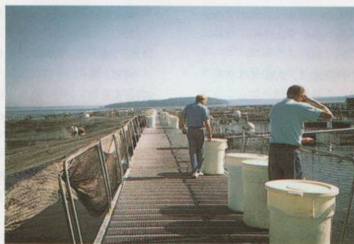
図6. フォークリフト等が通行できる網生簀筏構造(図4に示した養殖場)
