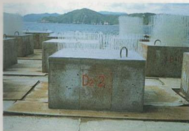
図-2 設置直前のブロック(D2型とB型)
