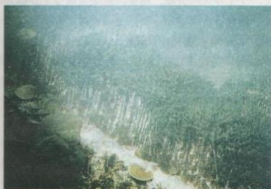
図-4 先端にミルが着生したD1型ブロック
