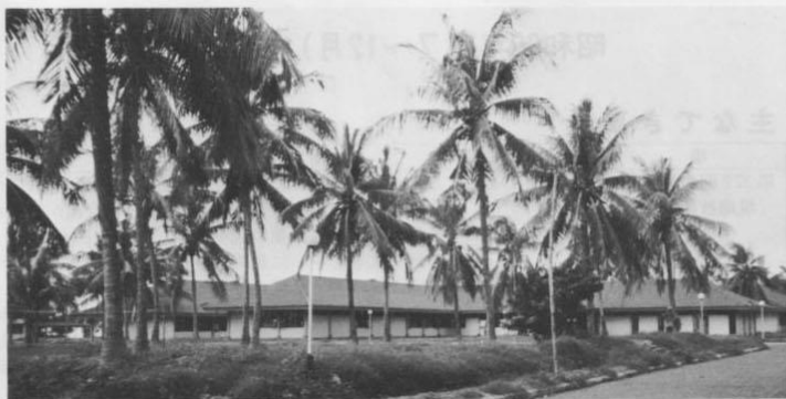
図4. バリ島のゴンドールに建設中の水産種苗センター
