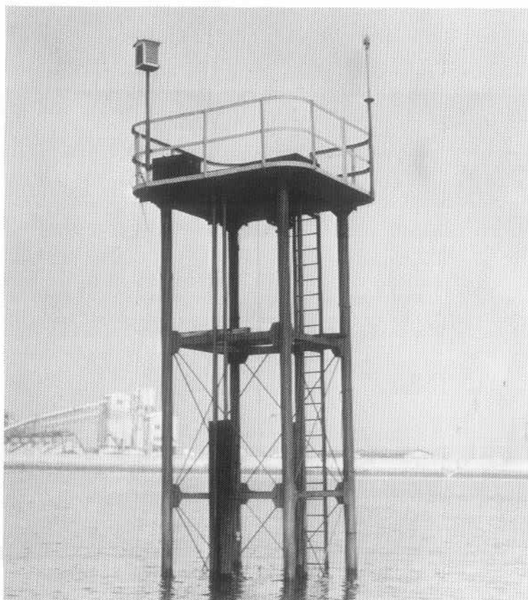
連続自記海況観測施設 Automatic Survey Tower.
