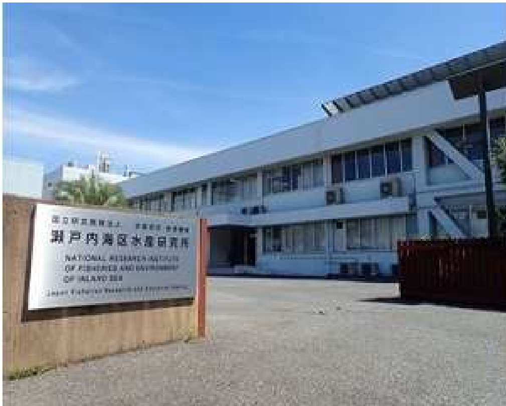
【瀬戸内海区水産研究所廿日市庁舎】
