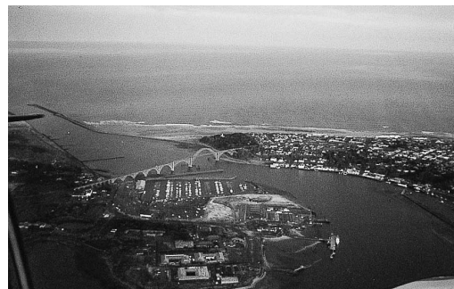
写真1．Yaquina Bay Bridge 近辺の航空写真。橋の 手前がオレゴン州立大学の海洋科学センター の敷地。
